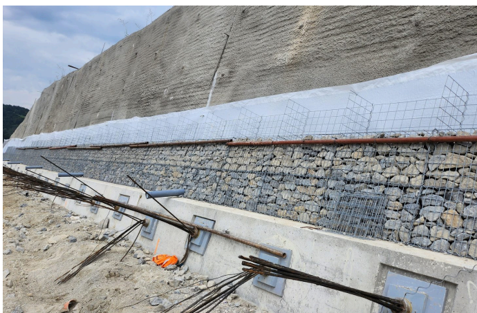
Inštalácia gabionového obkladu
