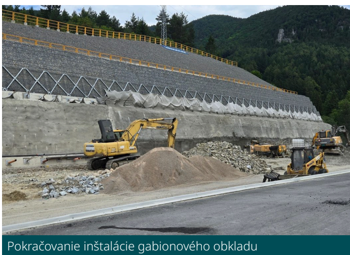
Inštalácia stabilizačného systému READY C115
