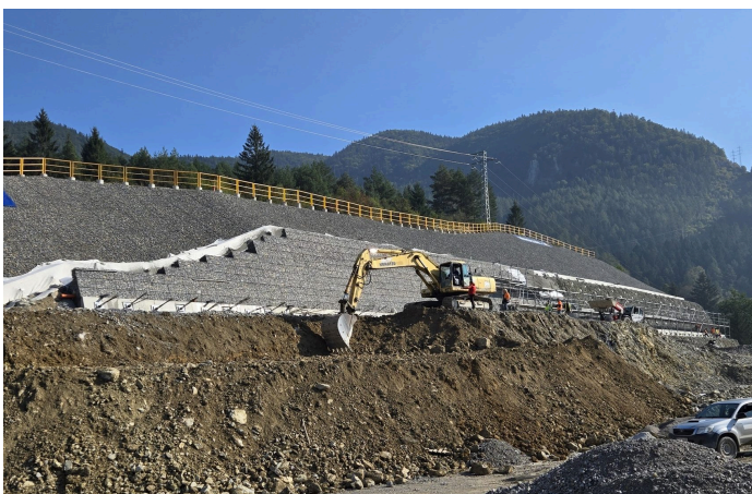
Inštalácia gabionového obkladu
