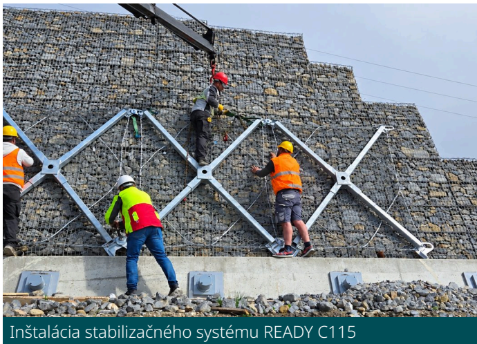
Inštalácia stabilizačného systému READY C115
