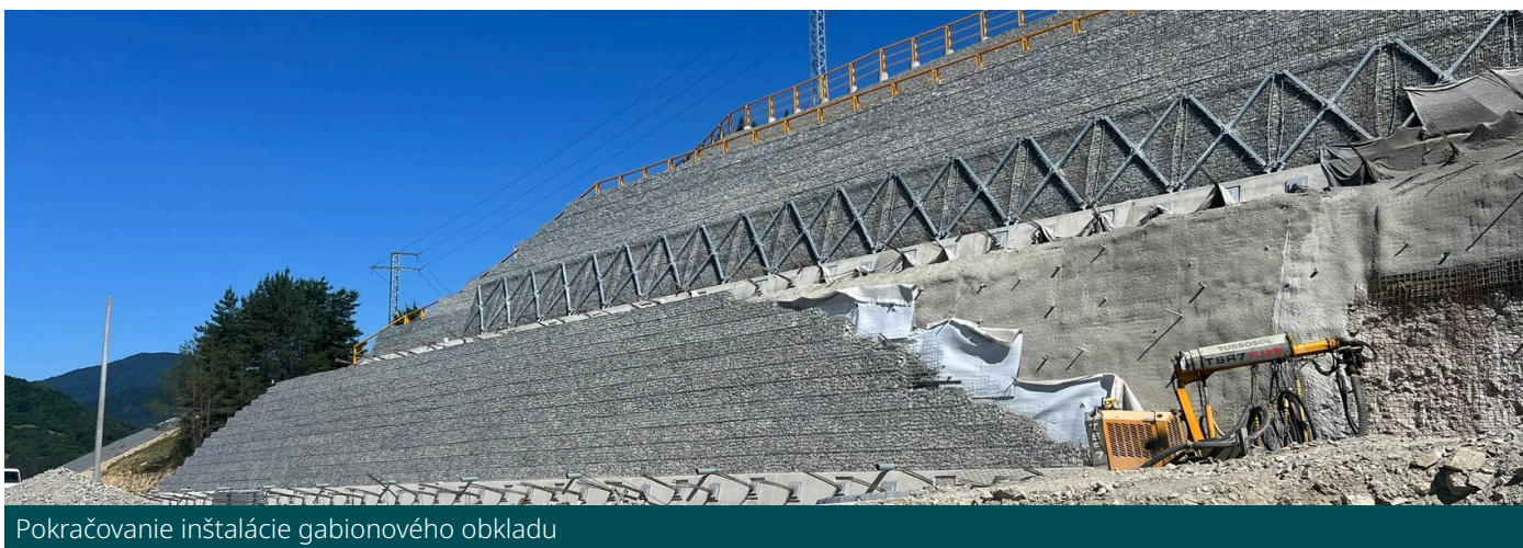
Pokračovanie inštalácie gabionového obkladu
