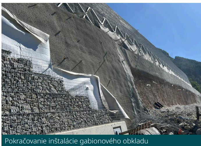
Inštalácia stabilizačného systému READY C115
