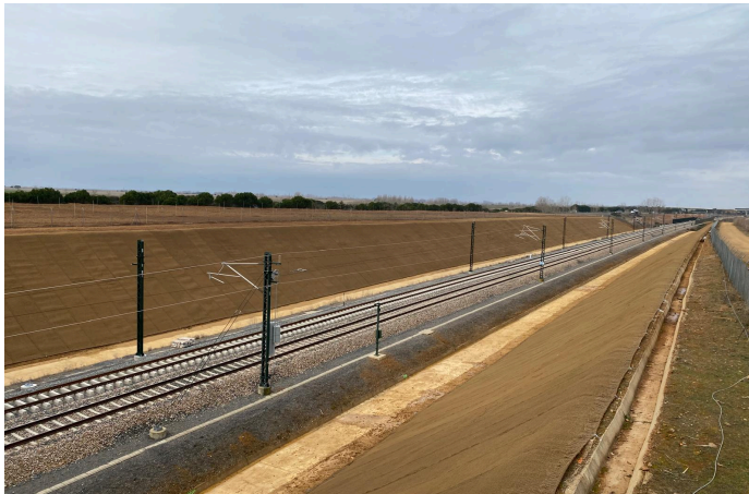
Vista de la membrana en coronación del talud
