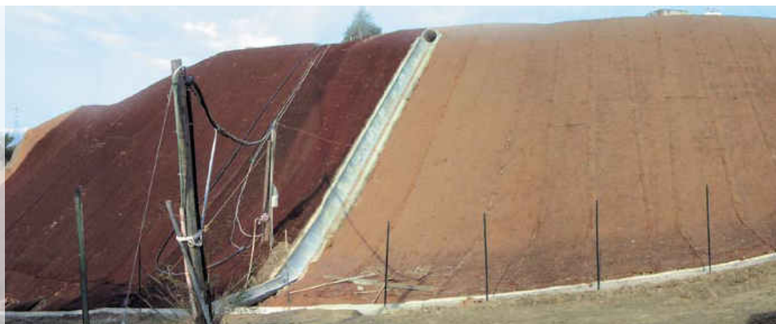
1. Биомат 2. Растительный слой почвы GG. Георешетка Парагрид или МакГрид WG GA. Усиленные дерном маты МакМат R GCL. Бентонитовый мат МакЛайн GCL GCD. Дренажный геокомпозит МакДрейн
