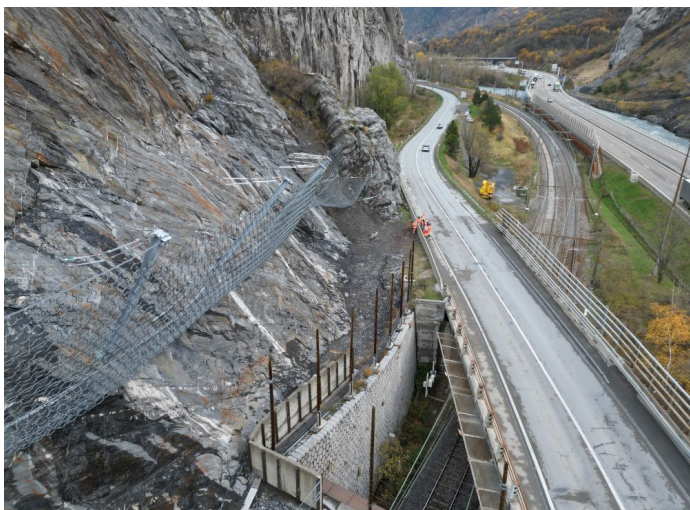
Vue d'ensemble des écrans pare-blocs
