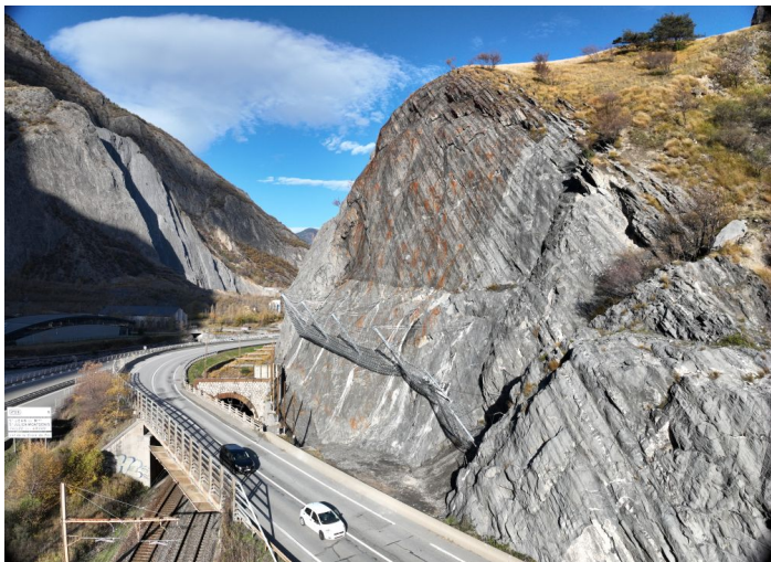
Vue aérienne des écrans et du versant fracturé
