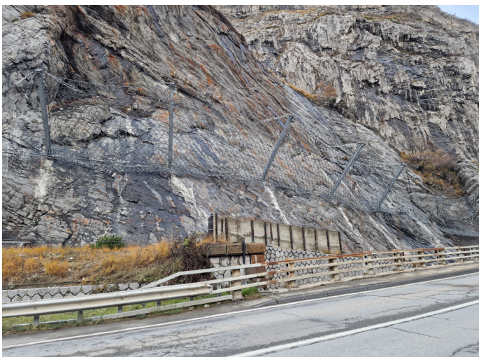
Vue aérienne des écrans en protection de la voie ferrée
