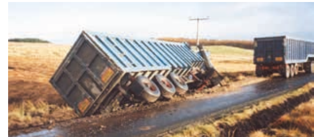
Renforcement des chaussées construites sur des sols tourbeux
