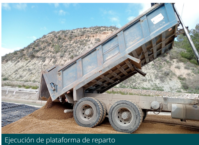
Extendido de las geomallas ParaLink 600 en la plataforma de
