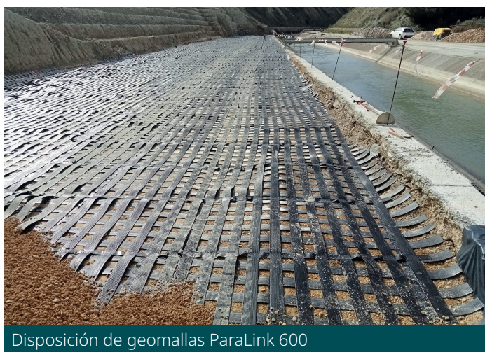
Ejecución de plataforma de reparto
