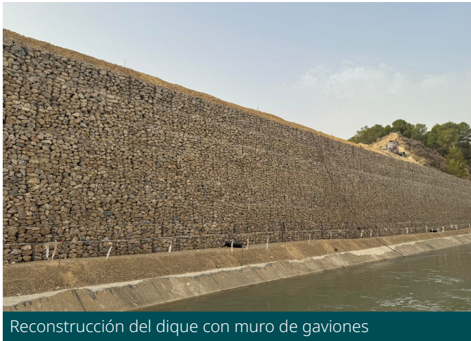
Ejecución de muro de gaviones completado
