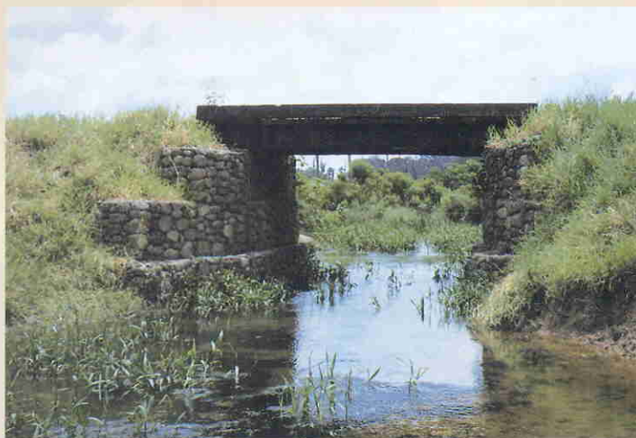
Primer Puente carretera Karpac Nueva Esperanza - Cochabamba
