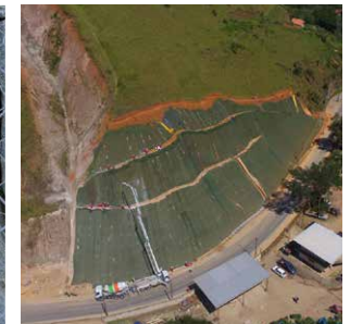
6 Soil Nailing y protección superficial
