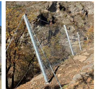
5 Barreras Dinámicas contra caída de rocas
