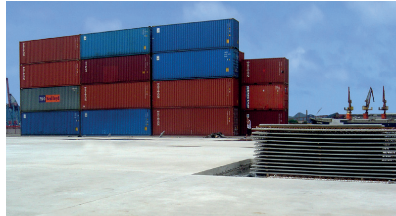
Piso fibro-reforzado con fibras de acero Wirand®
