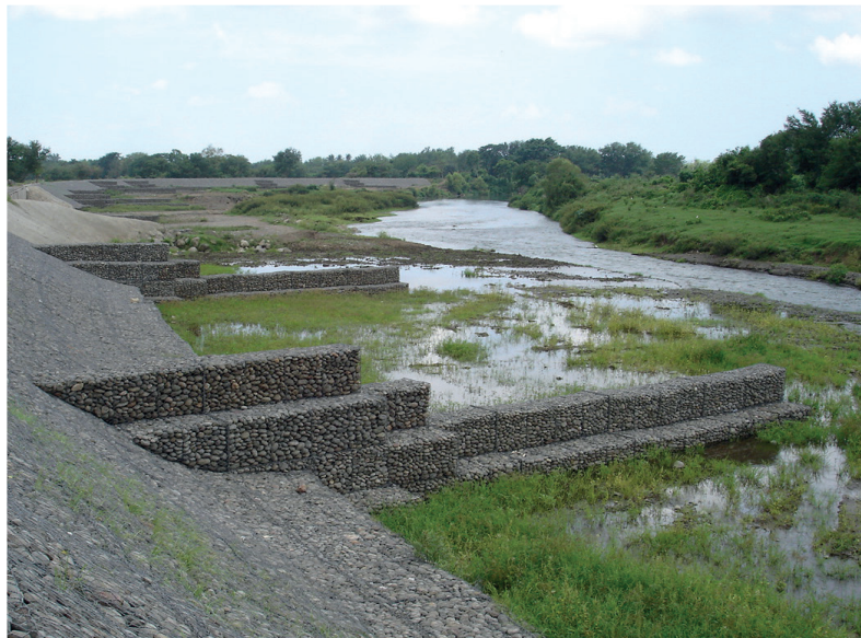
Obra longitudinal en Colchón Reno® con Espigones en Gavión Caja
