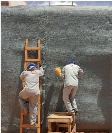
Drenaje vertical con geocompuesto MacDrain®
