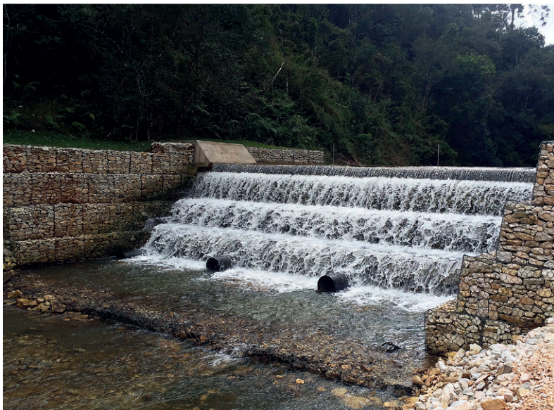
Obra transversal con Gavión Caja
