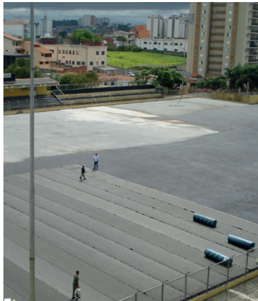
Drenaje horizontal con geocompuesto MacDrain®
