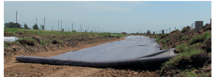
Filtración y Separación de suelo con geotextil MacTex®
