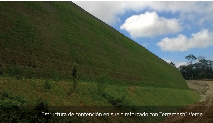
Estructura de contención en suelo reforzado con MacForce®
