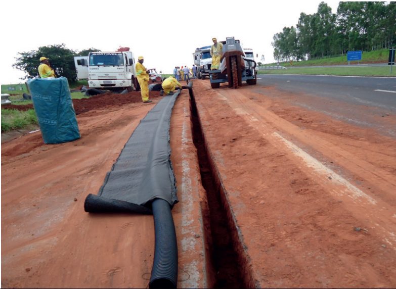
Trinchera drenante con geocompuesto MacDrain® TD y MacPipe®
