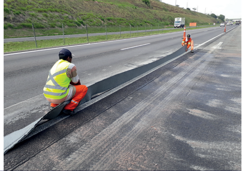
Drenaje de suelo en microvala con geocompuesto MacDrain® TD
