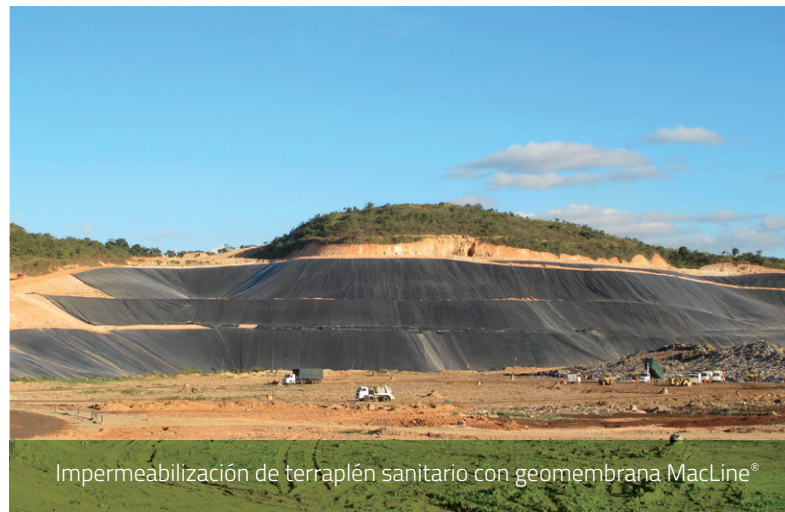
Impermeabilización de terraplén sanitario con geomembrana MacLine®
