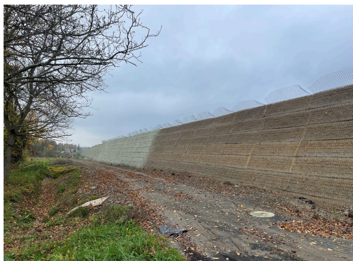
Pohled na konstrukci ze systému Green Terramesh, s
