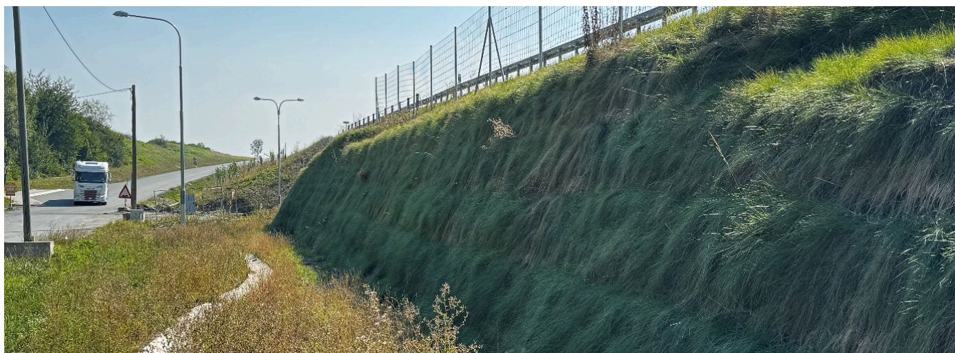
Pohled na dokončenou konstrukci ze systému Green Terramesh po dokončení výstavby
