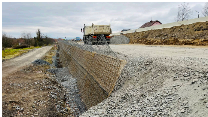
Pohled na instalaci systému Green Terramesh
