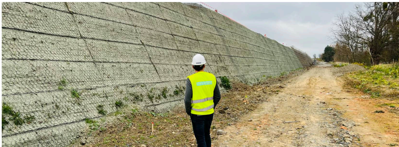
Vyztužené násypy ze systému Green Terramesh
