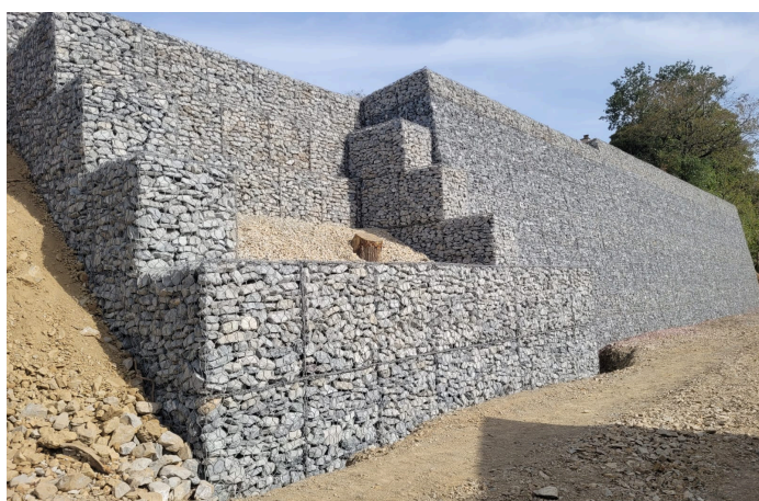
Vue du murs poids gabions et du remblai renforcé en
