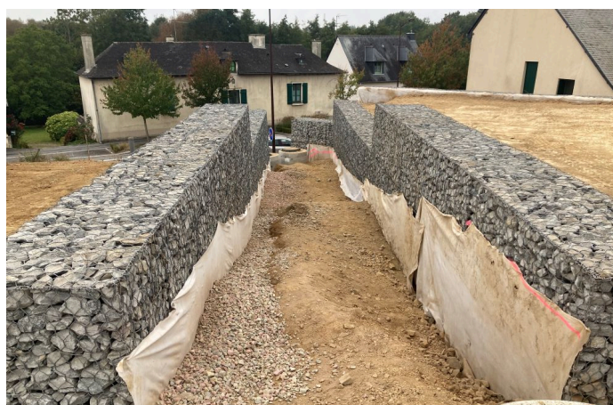
Murs poids en gabions pour la création en escaliers de la
