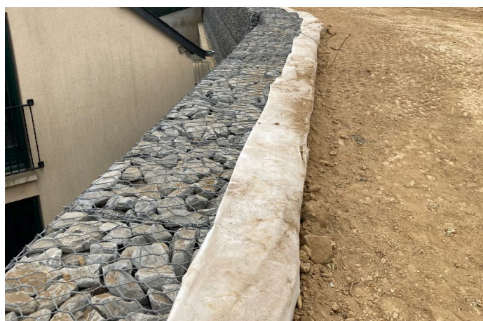
Vue de l'arrière du mur
