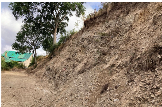
Avant le commencement des travaux
