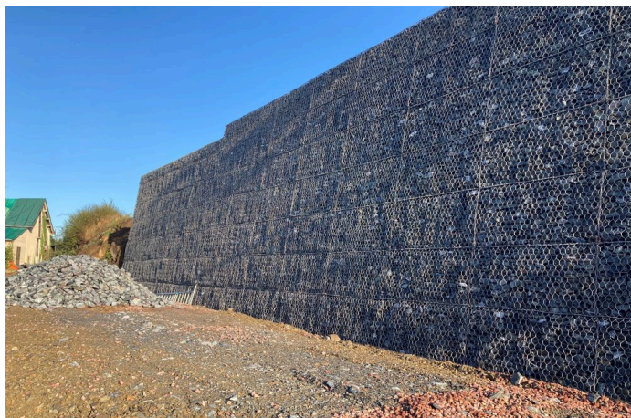
Remblai renforcé réalisé avec la solution en TerraMesh
