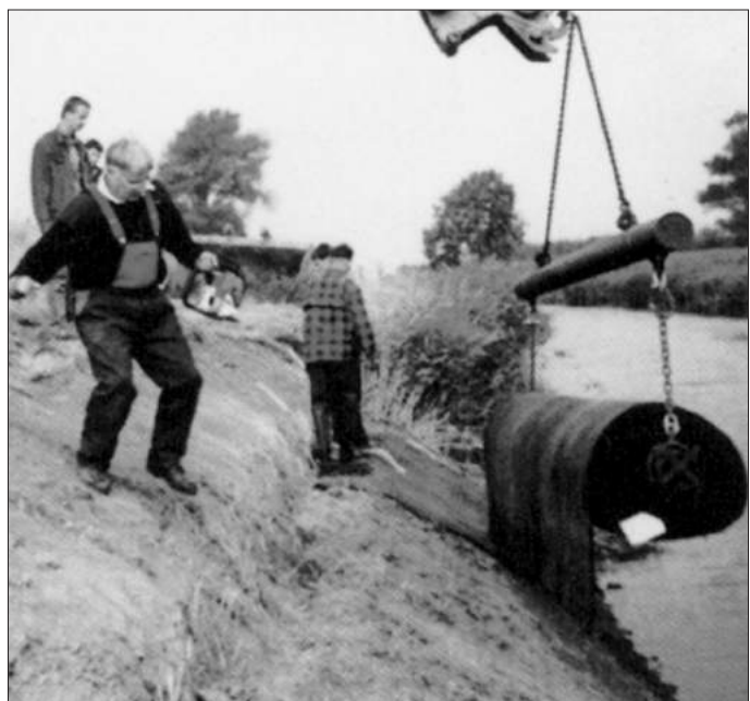
Figura 2.3.8 - Colocación del MacMat ® S sellado con asfalto con el auxilio de una grúa.
