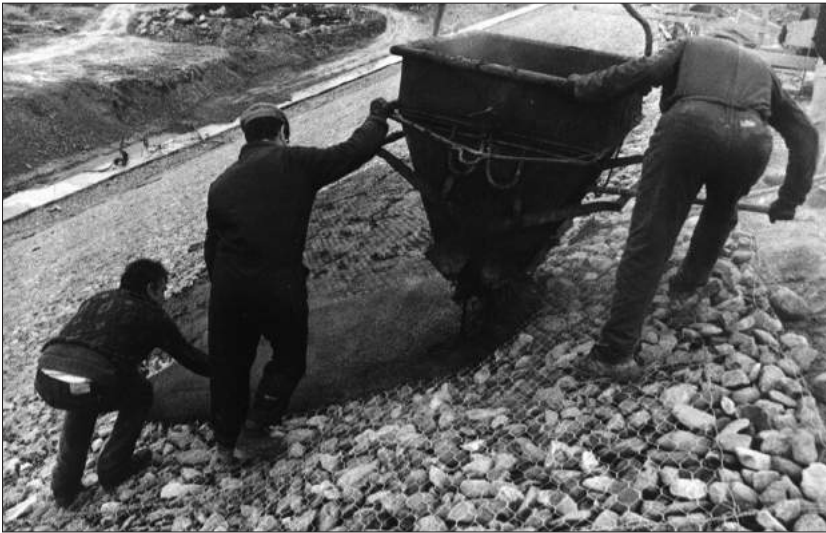
Figura 2.2.21 - Operación de recubrimiento de colchones Reno®.
