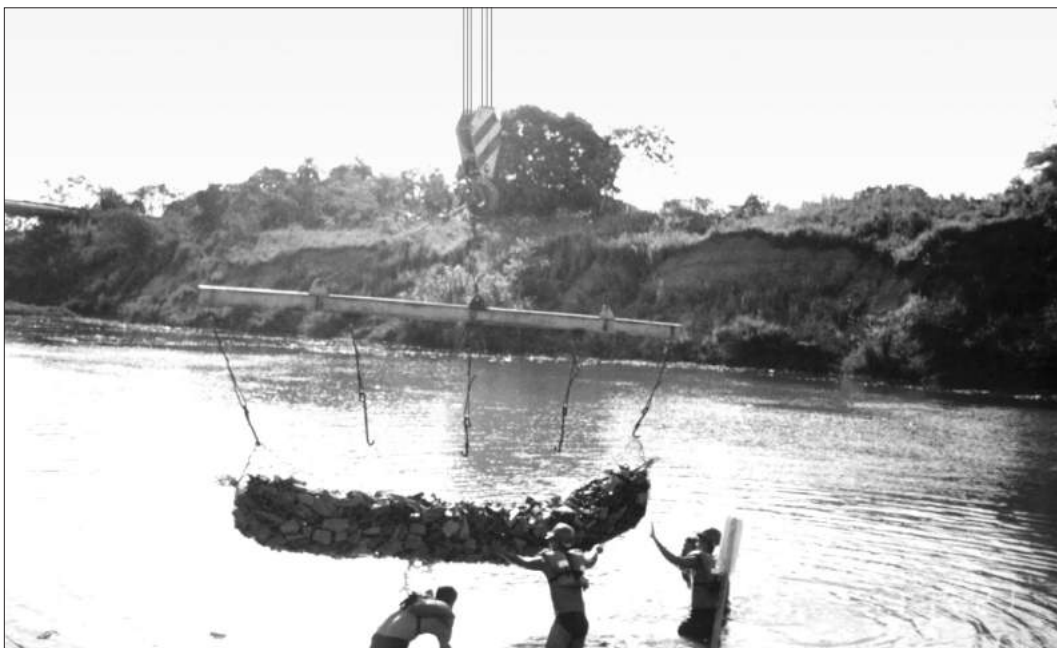
Figura 2.2.15 - Colocación de gavión saco para la construcción de un muro de contención - Brasil.
