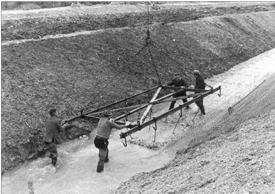
Figura 2.2.6 - Colocación de colchones Reno® en presencia de agua.
