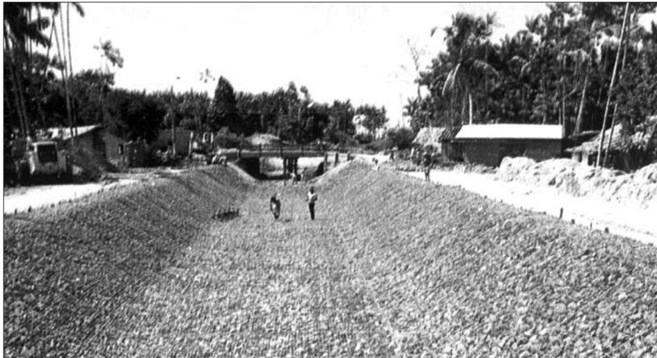
Figura 2.2.3 - Canalización en colchones Reno®.
