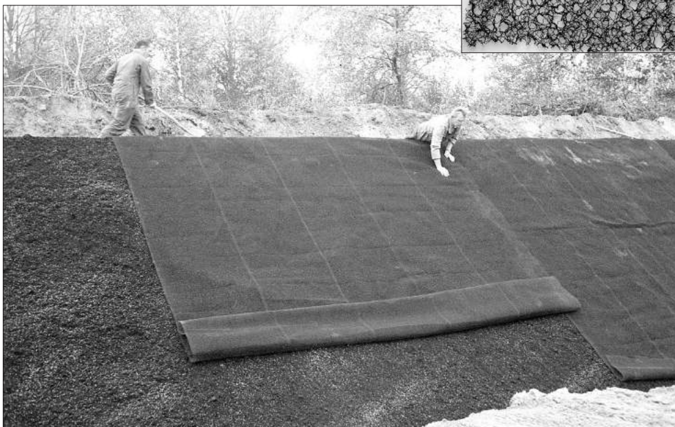
Figura 2.3.2 - Colocación de la geomanta.
