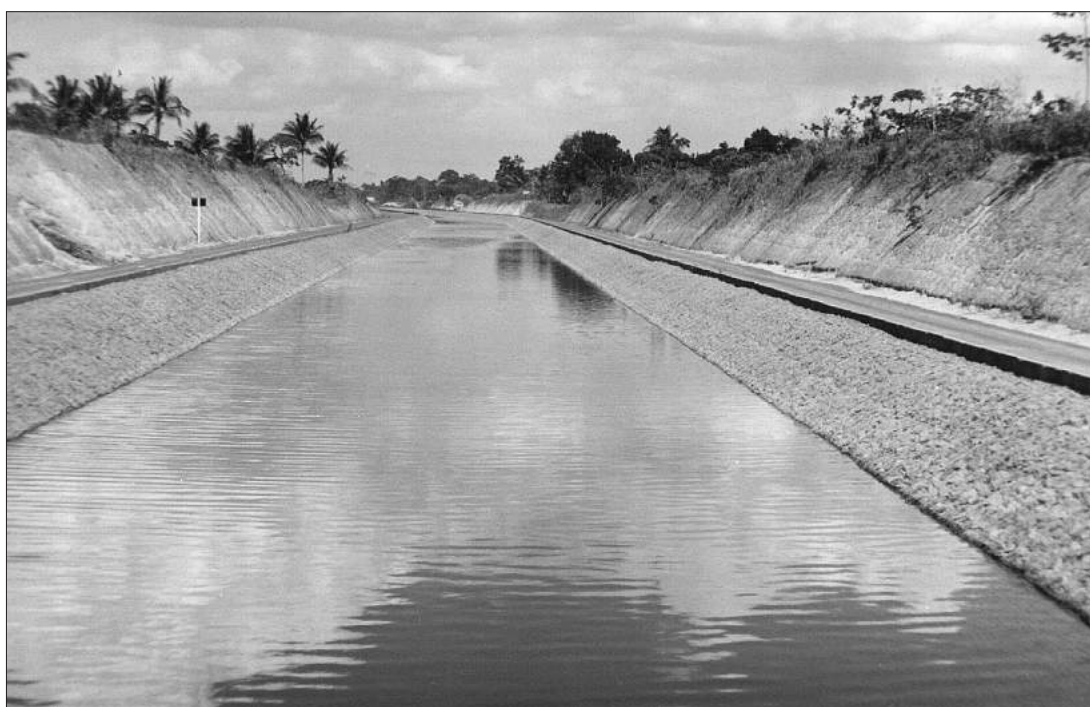
Figura 3.4.19 - Canal adutor de Pedra do Cavalo, revestimiento con colchón Reno® - Bahia - Brasil.
