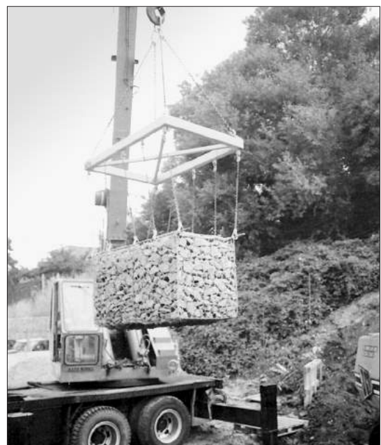
Figura 2.2.10 - Gavión caja siendo trasladado con grúa.
