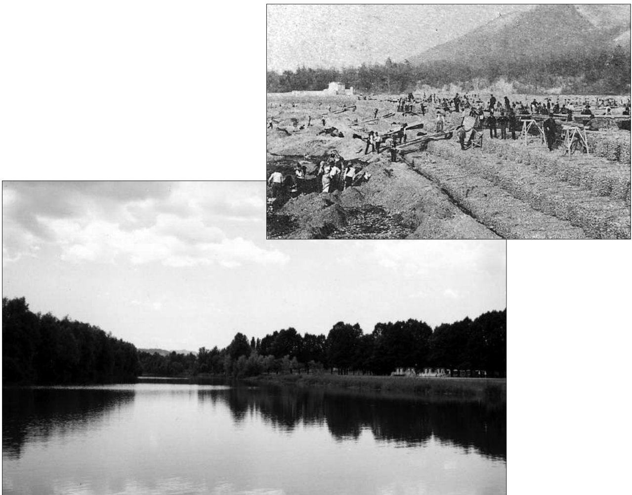
Figura 2.1.1 - Primera obra en gaviones metálicos realizada en Italia en 1892.
