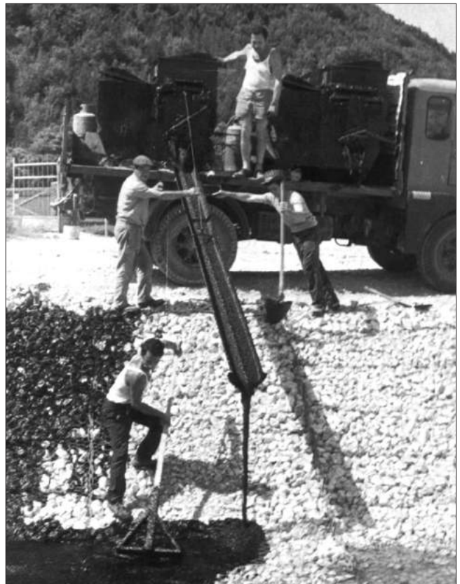
Figura 2.2.22 - Operación de recubrimiento de colchones Reno® con mezcla bituminosa.
