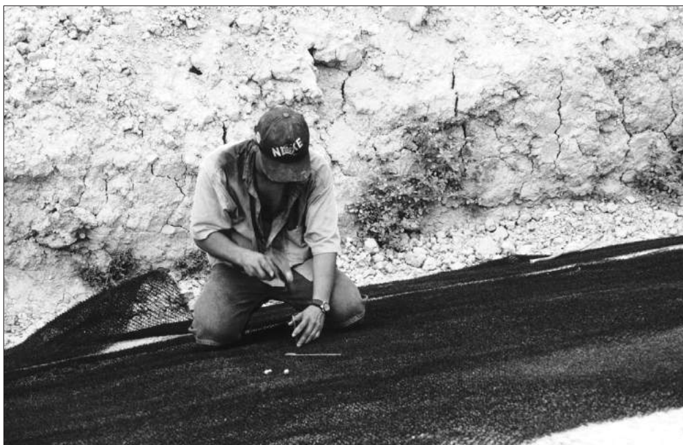
Figura 3.5.1 - Colocación de la geomanta.
