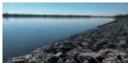
Photo 2 – Ouvrage hydraulique en RenoMac Plus avec revêtement PoliMac, installé en protection de berges du Rhin (milieu agressif), Bief de Gamsheim (Bas-Rhin).
