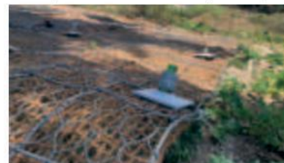
Photo 3 – Filet MacArmour Bio PoliMac en cours de mise en place sur un talus en aval de l'autoroute A8 (milieu agressif), Mougins (Alpes-Maritimes).
