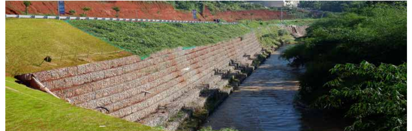
Kombinasi Paramesh, Reno® Matress, Gabion, dan MacMat® HS - CitraGran Cibubur, Jawa Barat
