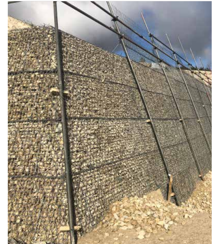
Mineral Terramesh® - Tahap konstruksi
