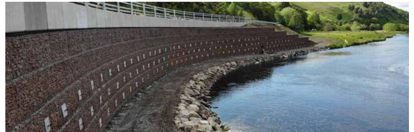
Kombinasi Gabion dan Paramesh - Britania Raya
