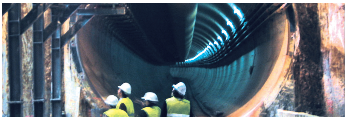
Inspección de la obra
