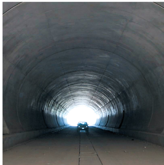
Túnel con dovelas de hormigón reforzado con fibras.
