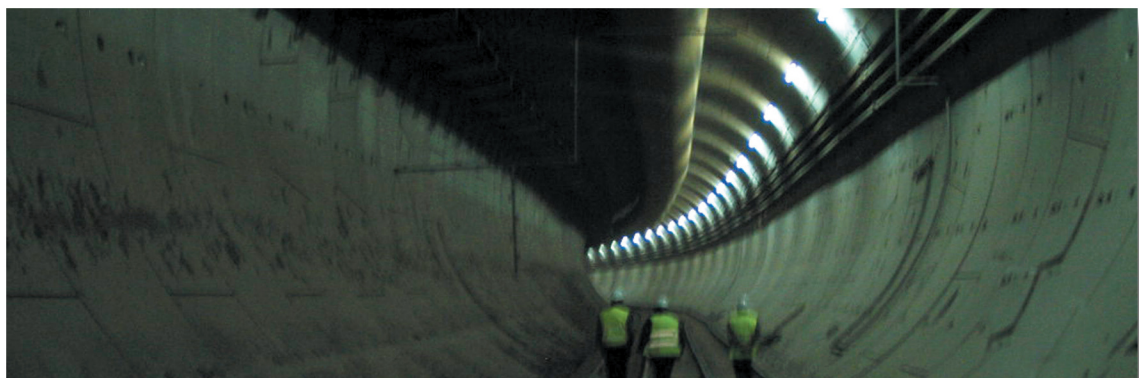
Inspección de la obra
