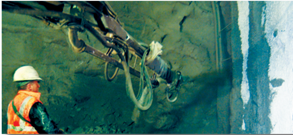
Hormigón proyectado con fibras.
