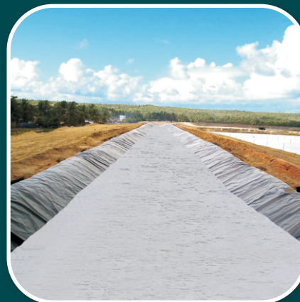
Canales de aducción
