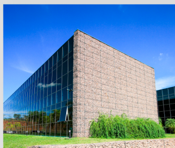
Revestimento de fachada com Gabião Caixa
