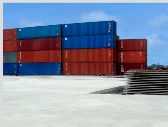
Piso fibra-reforçado com fibras de polipropileno FibroMac®
