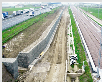
Barreira de Segurança com Terramesh® System
