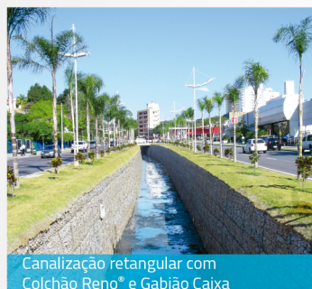
Muro de contenção em Gabião Caixa
