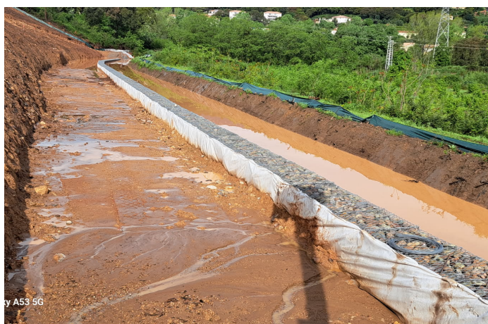
Vue de l'ouvrage par l'arrière et du géotextile
