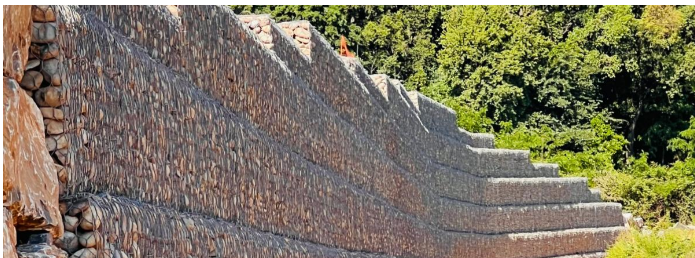
TerraMesh® System avec parement en gabions avec grillage double torsion et revêtement polymère PoliMac®
