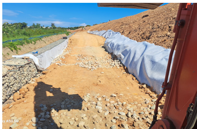
Cage en gabions en cours de mise en oeuvre
