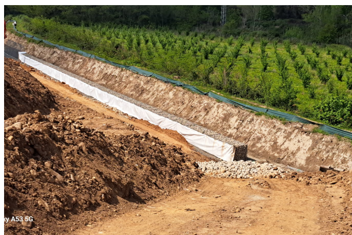
Vue du chantier en cours
