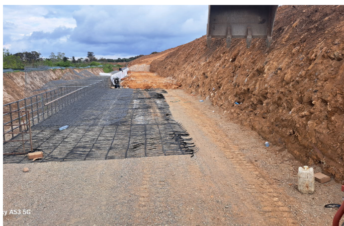
Pose des structures pour la mise en place de la solution en
