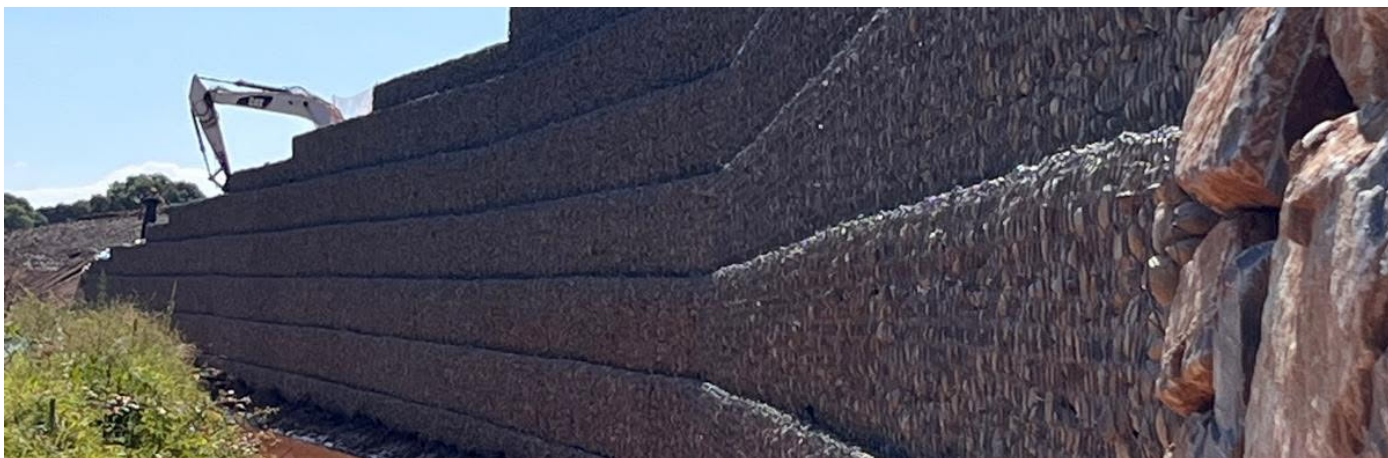
Hauteur du mur variable entre 3.50 et 7m de hauteur
