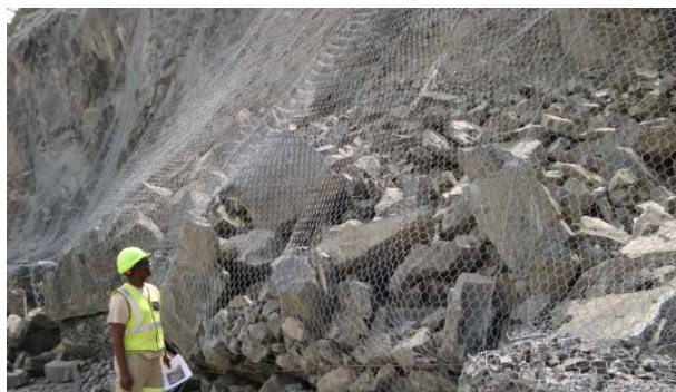
Revestimiento simple de talud con SteelGrid®
