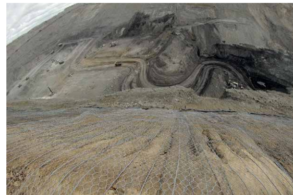
Revestimiento cortical de talud con SteelGrid®
