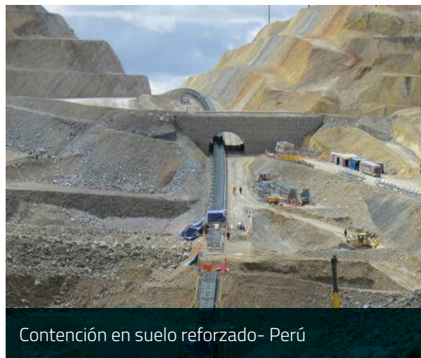
Contención en Suelo Reforzado – Perú
