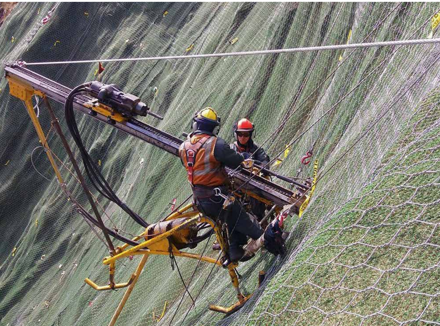
Revestimiento de taludes con geomanta MacMat®
