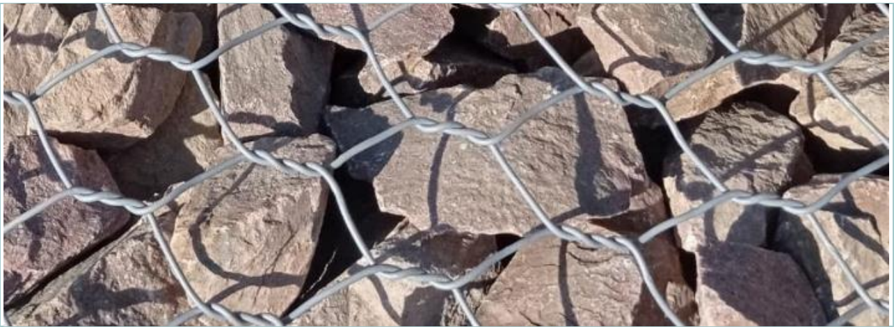
Figura 1 | Malla metálica hexagonal de doble torsión sobre piedra de cantera
