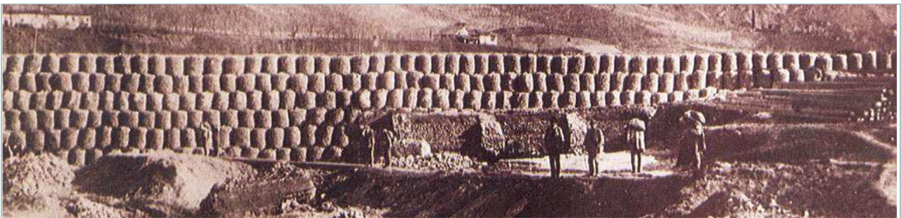
Figura 19 | Obra del Río Reno con gaviones en 1894
