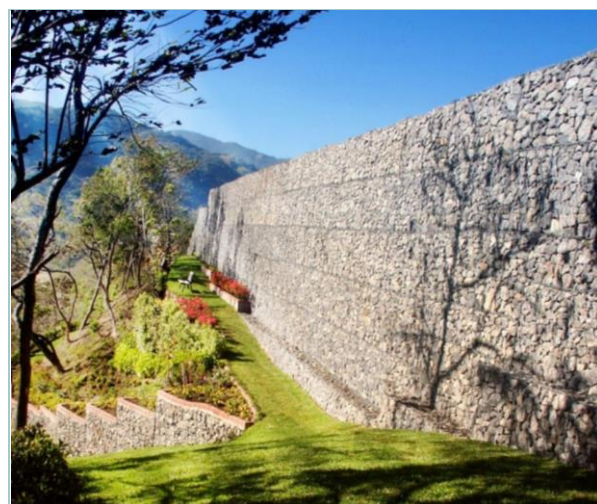
Figura 4 | Muro de contención por gravedad
