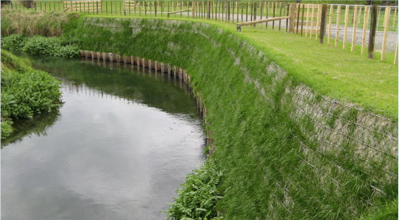
Figura 8 | Muro de contención de Terramesh® Verde
