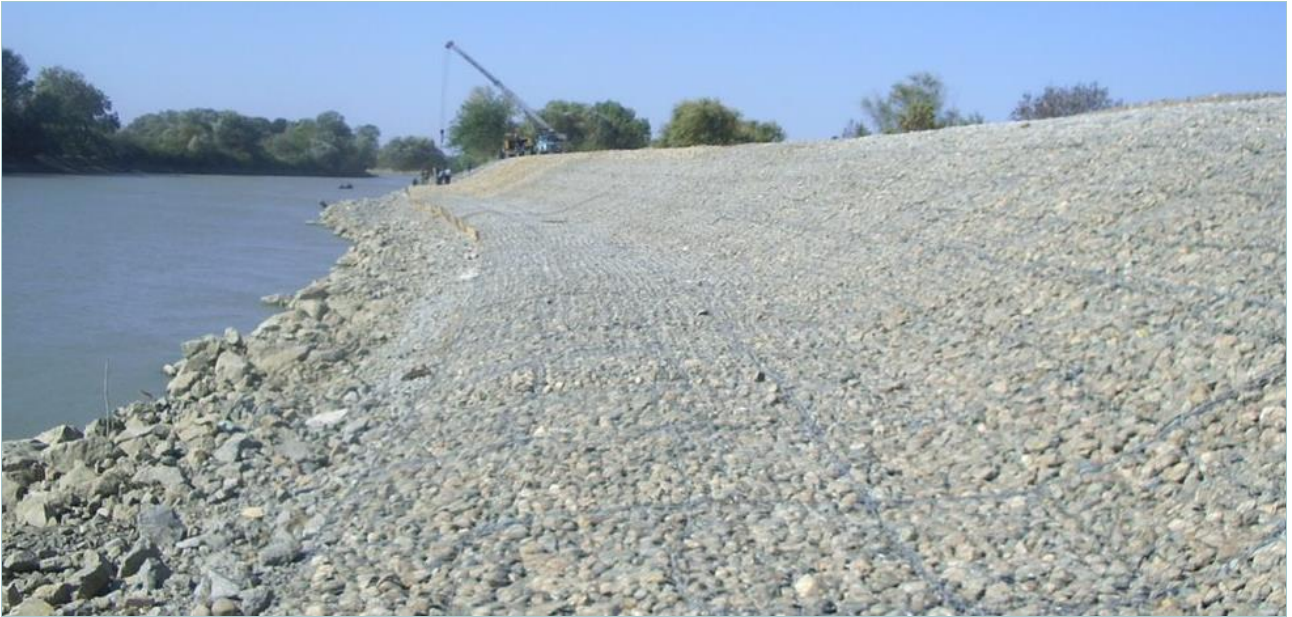
Figura 10 | Revestimiento de margen con Colchón Reno®
