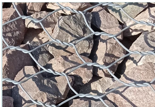
Figura 29 | Elemento de MHDT con revestimiento adicional polimérico instalado en obra (llenado con piedras)
