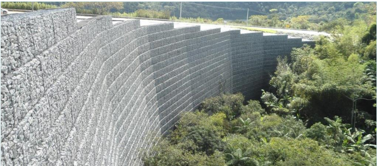
Figura 6 | Muro de contención de Terramesh® System
