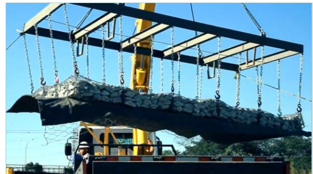
Figura 15 | RenoMac® izado para instalación
