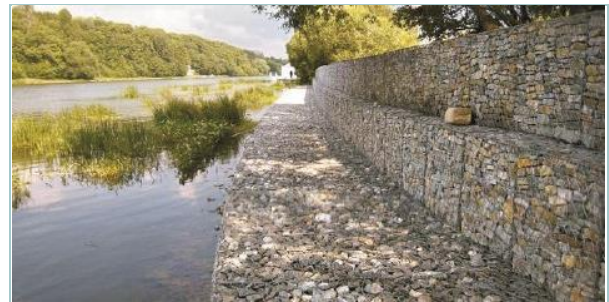
Figura 11 | Muro con plataforma de colchón
