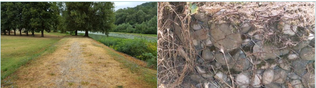
Figura 20 | (a) Obra del Río Reno con gaviones en 2016; (b) Presencia de malla en la obra del Río Reno
