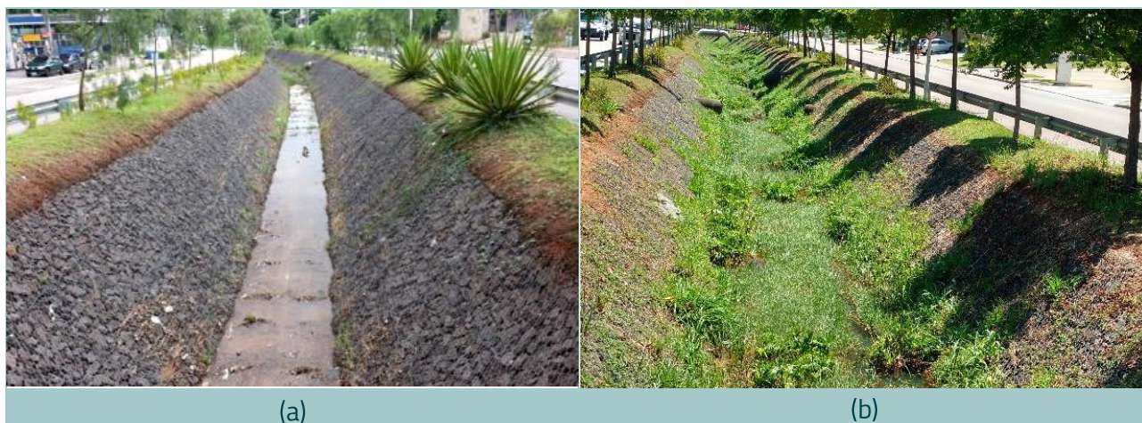
Figura 18 | Fotos de un canal revestido con Colchón Reno® en Jundiaí-SP, Brasil en (a)2014 y (b)2017
