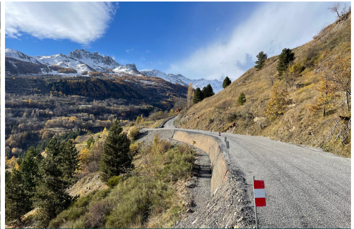
Vue d'ensemble du chantier terminé
