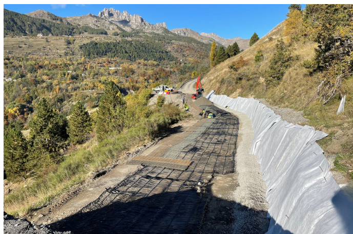
ParaGrid® 100 mise en place avant le remblai
