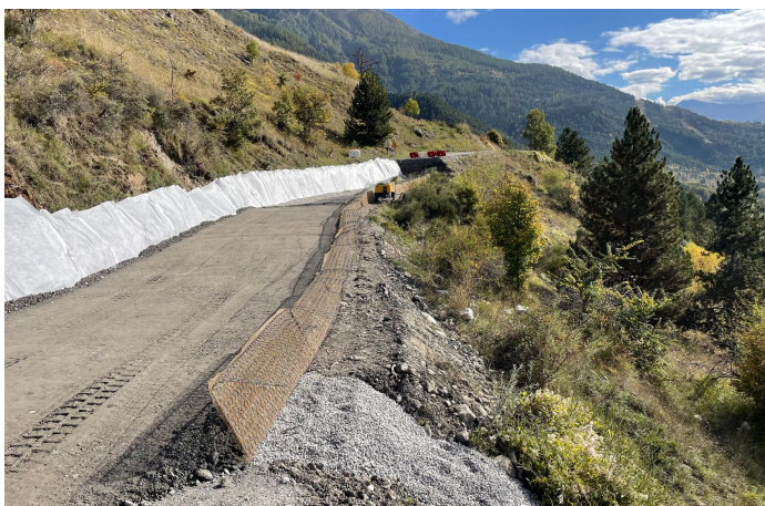
Mise en place de la solution avec géocomposite de drainage
