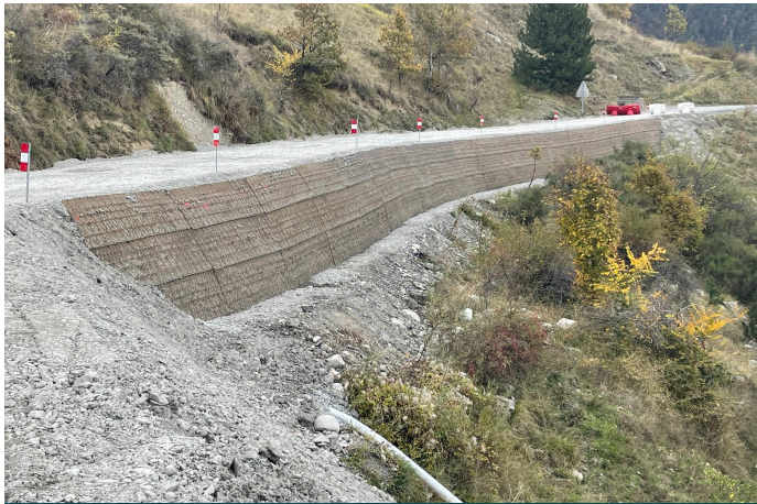
Chantier en fin de réalisation
