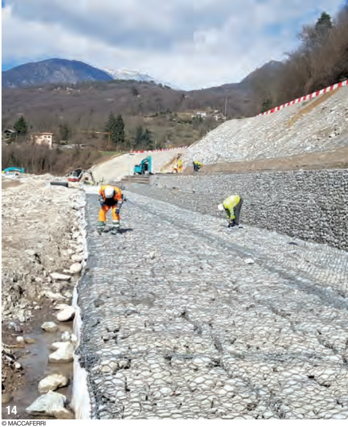
14- Protection de berges à La Bollène en Vésubie.
