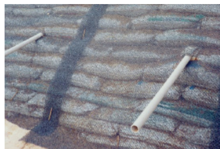
Foto 6 - Revestimiento de la superficie de una recuperación de erosiones en cara envuelta con MacMat® 10.1
