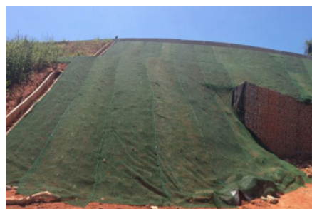
Foto 1 - Revestimiento de talud por encima de un muro de contención en gaviones con MacMat® R3
