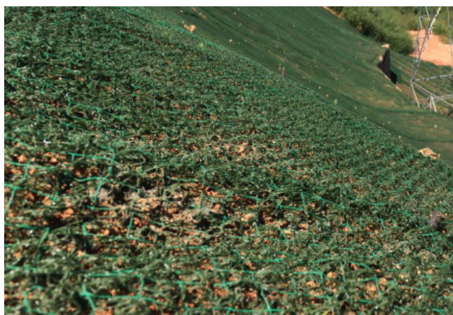
Revestimiento de talud con MacMat® R3
