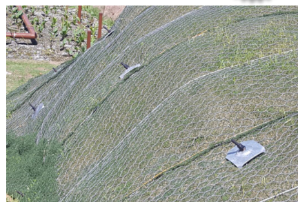
Foto 3 - Revestimiento de la superficie de un suelo grapado con MacMat® HS
