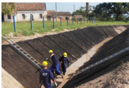
Foto 2 - Revestimiento de canal de drenaje de aguas pluviales con MacMat® 10.1
