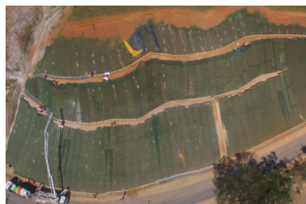
Foto 4 - Revestimiento de la cara de un suelo grapado con MacMat® R1
