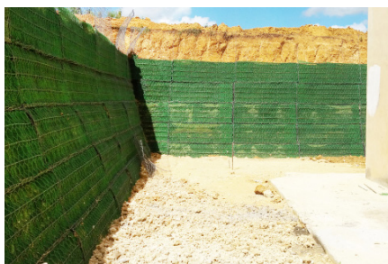
Foto 5 - Revestimiento de la cara de contención en suelo reforzado con MacMat® 10.1
