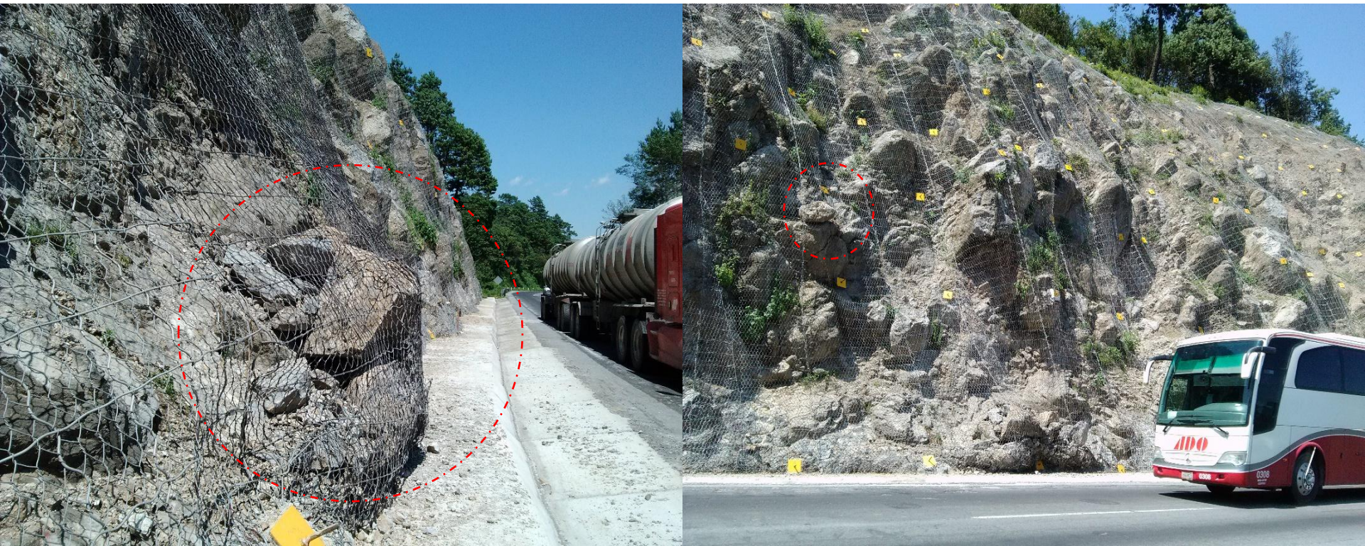
Talud estabilizado Km 230+000 Cuerpo "B" Autopista Córdoba – Cd. Mendoza Veracruz.
