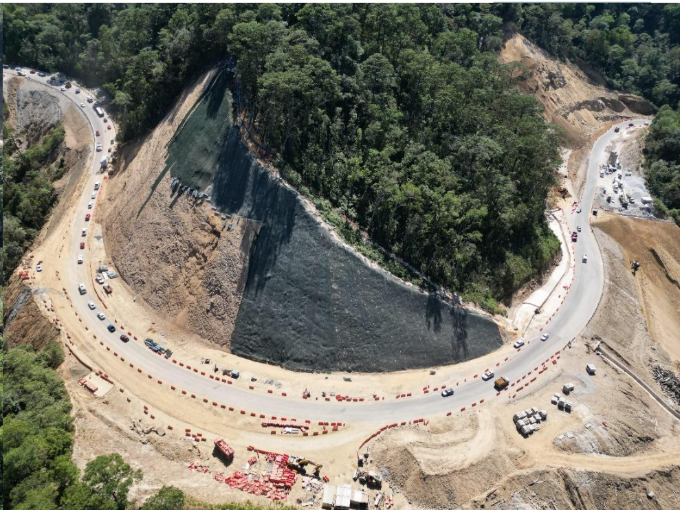
Autopista Barranca – Larga Ventanilla km 49+100 al 49+400
