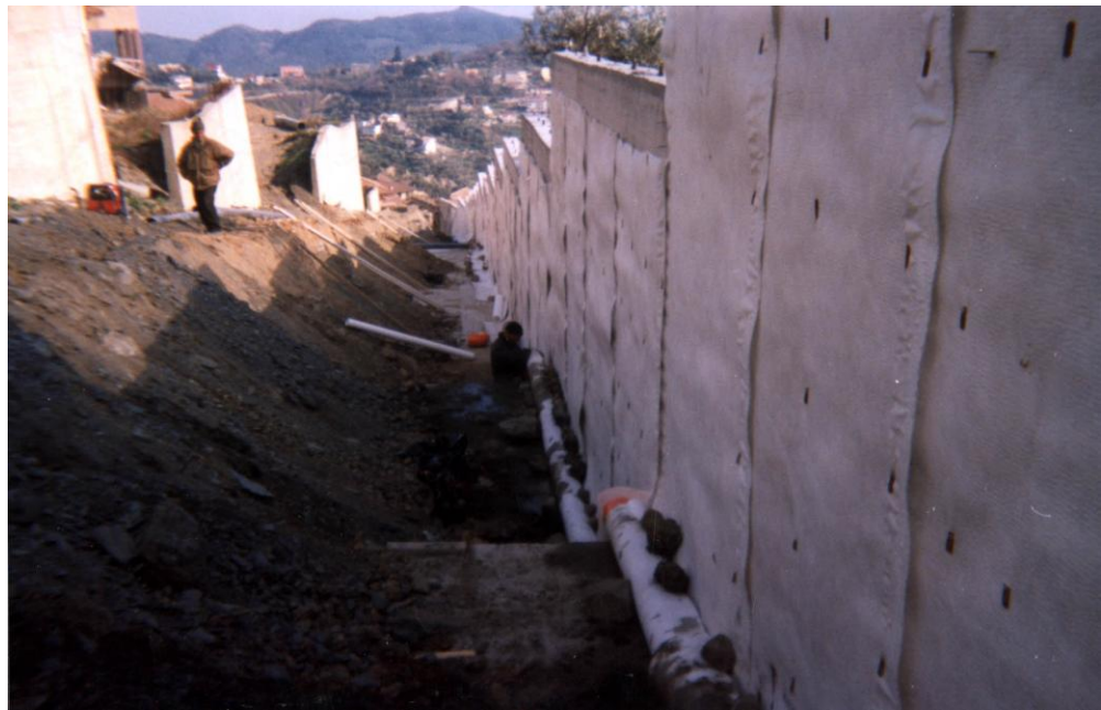
Colocación de geocompuesto
