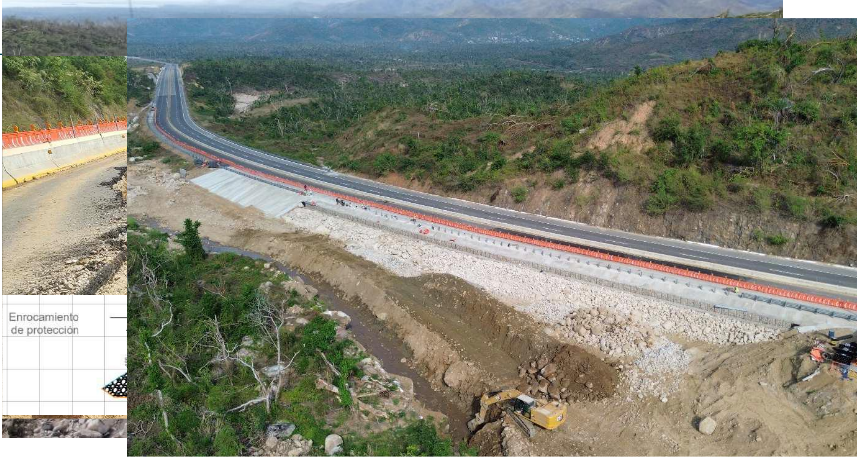
Falla de terraplén y talud, libramiento poniente de Acapulco, Huracán Otis, Octubre 2023.
