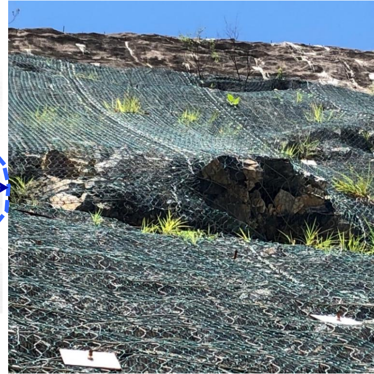
Roca contenida entre la malla
