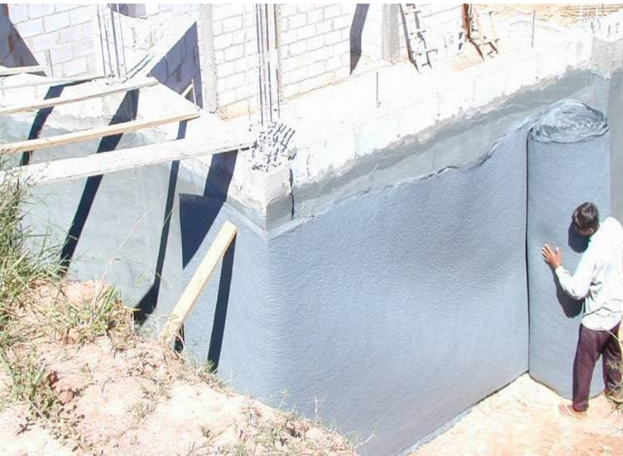
Colocación de geocompuesto
