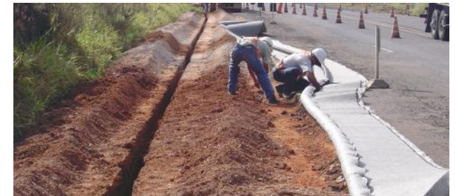
Zemin stabilizasyonu ve kaplama çözümleri
