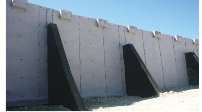
Otoyol hendek drenajı
