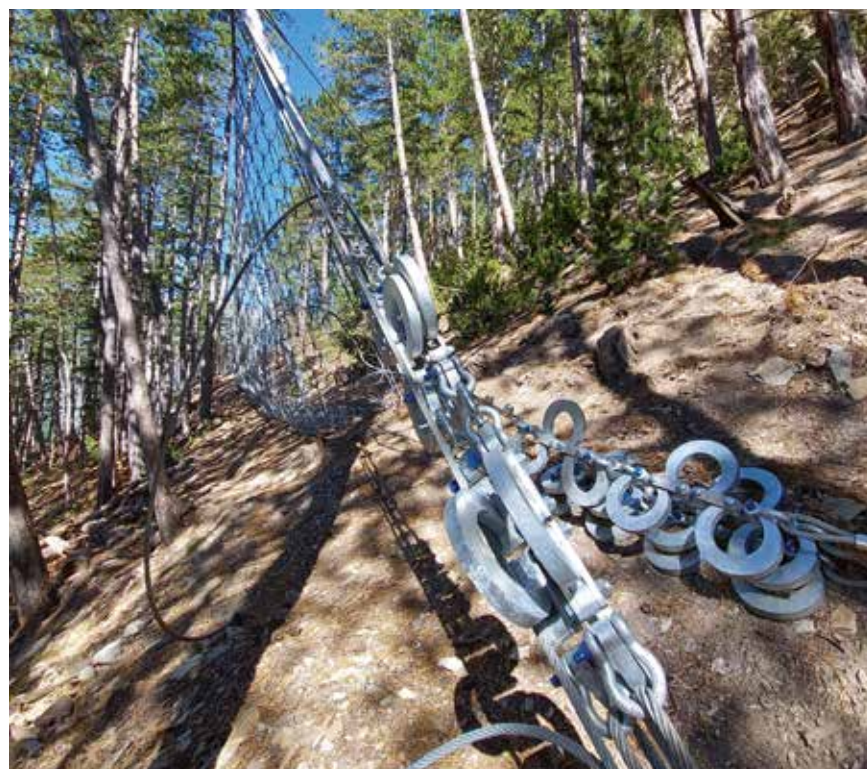
Écran pare-blocs RB2000 – Détail des dissipateurs d'énergie.
