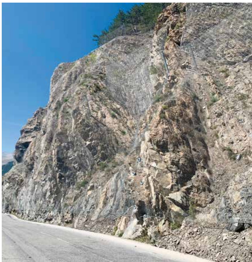
Avaloirs composés de dissipateurs d'énergie et filets à anneaux MacRing.
