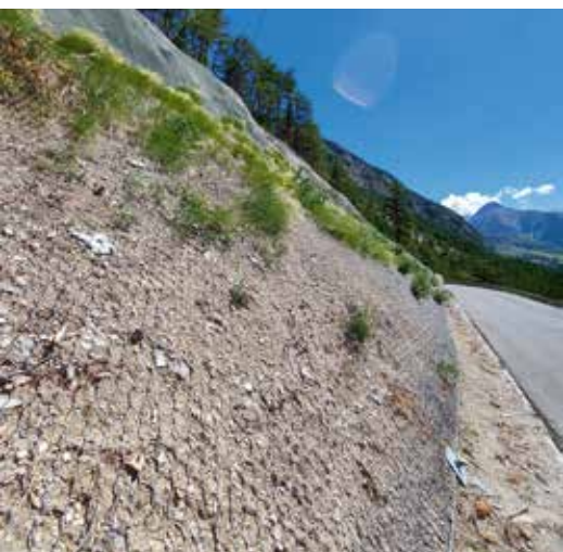
Grillage double torsion de protection de falaise ; MacMat R plaqué.
