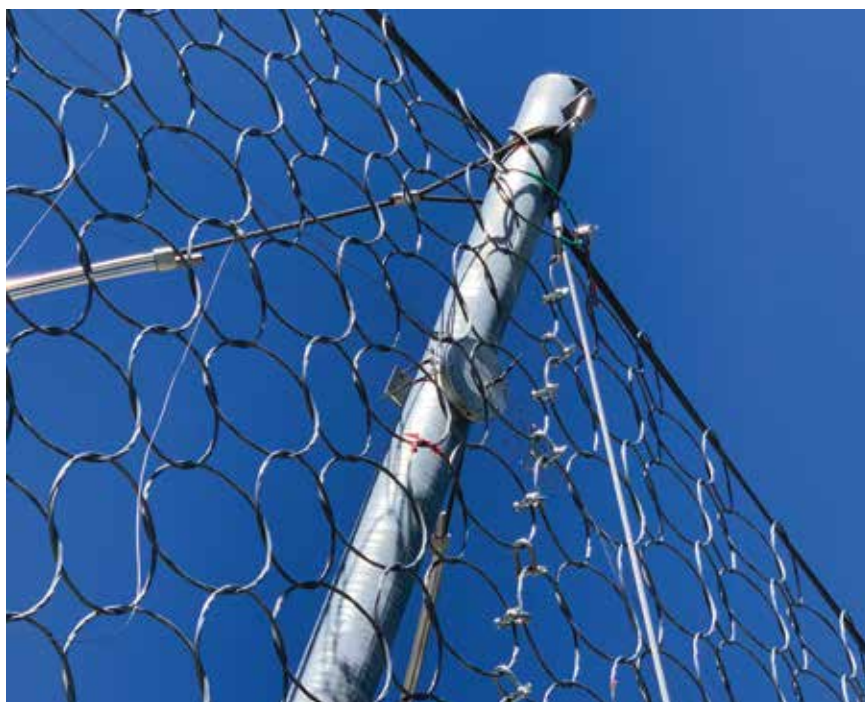
Système d'alerte HelloMac sur une barrière dynamique EPFM 5000.
