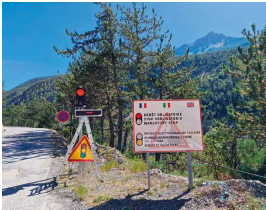
Les centrales d'acquisition actionnent en cas d'impact les signaux d'alerte.
