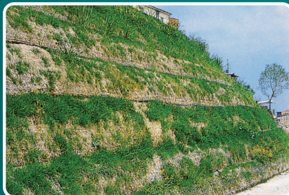
Ejemplo de evolución ambiental de estructuras en suelo reforzado Terramesh® Verde
