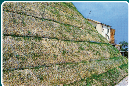
Ejemplo de evolución ambiental de estructuras en suelo reforzado Terramesh® Verde
