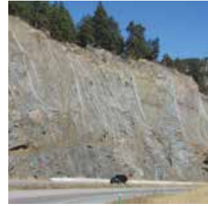
2 Basit tel ağ sistemleri- Yüzeysel örtüleme
