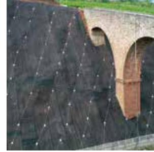
6 Zemin çivisi ve yüzeysel stabilizasyon uygulamaları
