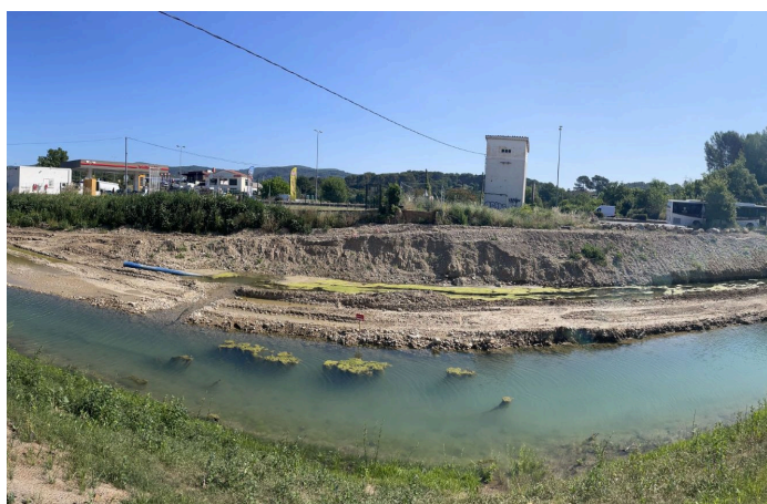
Vue d'une partie du chantier avant les travaux
