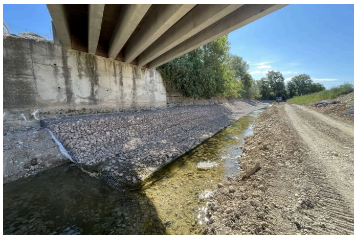
Matelas Reno® Plus suivants les courbes du terrain
