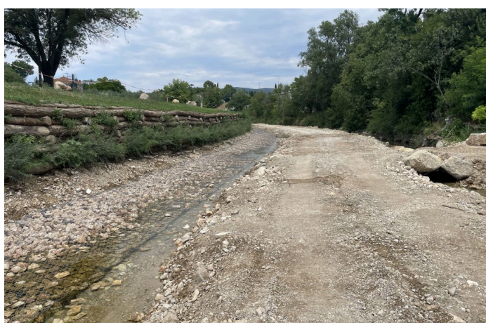
Matelas Reno® Plus comme solution anti-affouillement
