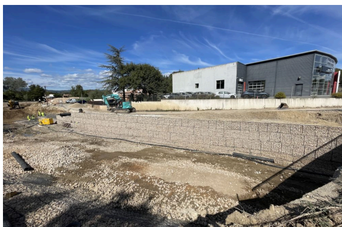
Mur poids en gabions double torsion
