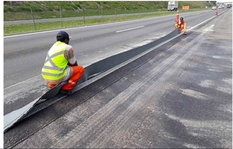
Drenaje de suelo en microvala con geocompuesto MacDrain® TD
