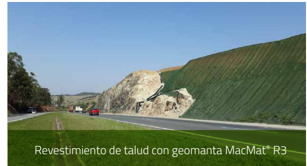
Revestimiento de talud con geomanta MacMat® R3
