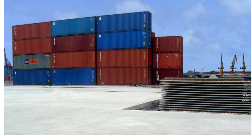
Piso fibro-reforzado con fibras de acero Wirand®
