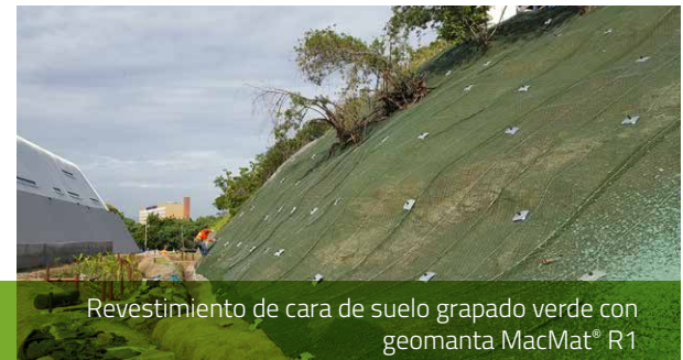
Revestimiento de talud con geomanta MacMat® R3
