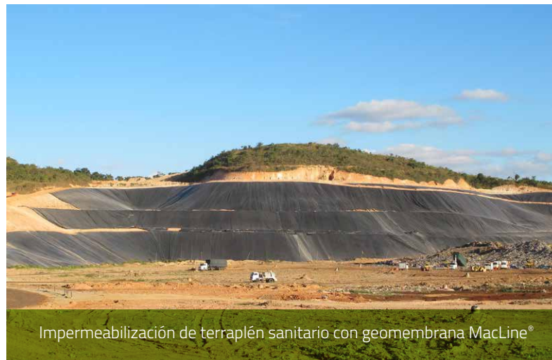
Impermeabilización de terraplén sanitario con geomembrana MacLine®
