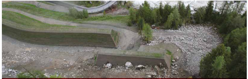
Sistemas Mac.RO.® de protección contra caída de rocas con Barrera Estática
