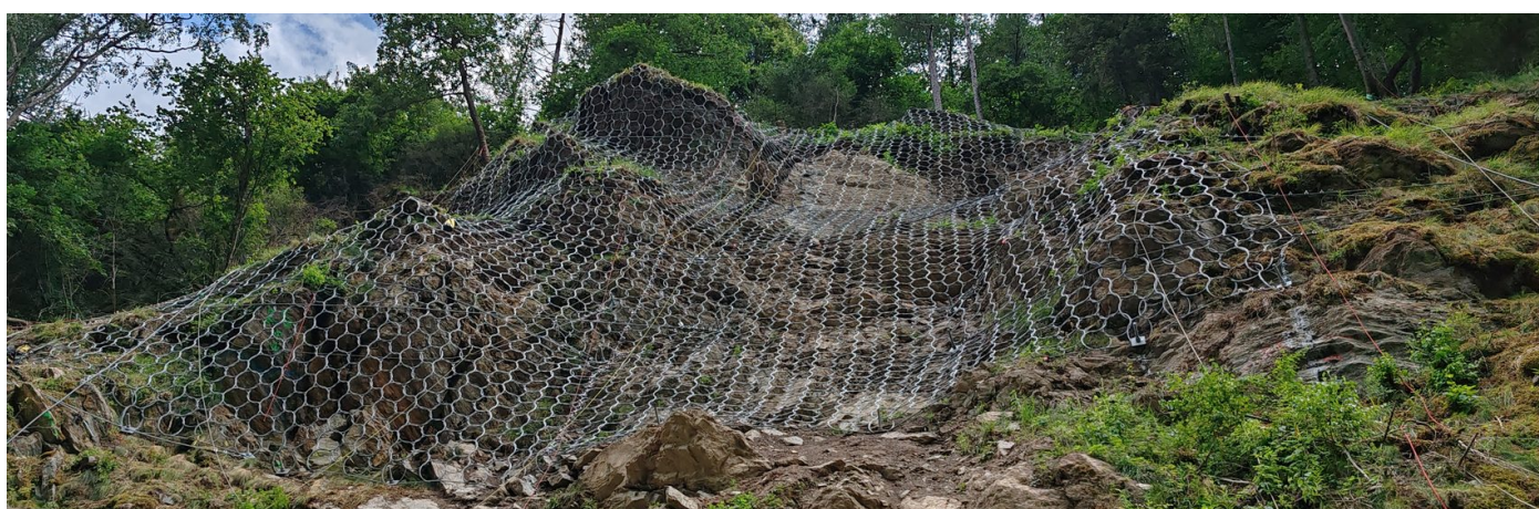
Vue du confortement du glissement rocheux
