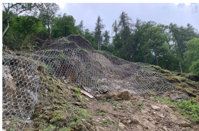
Emmaitotage en cours
