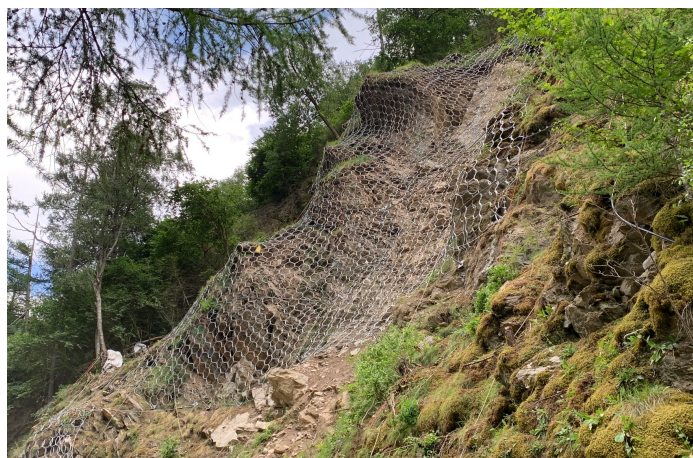
Sécurisation des masses rocheuses en cours avec le filet à
