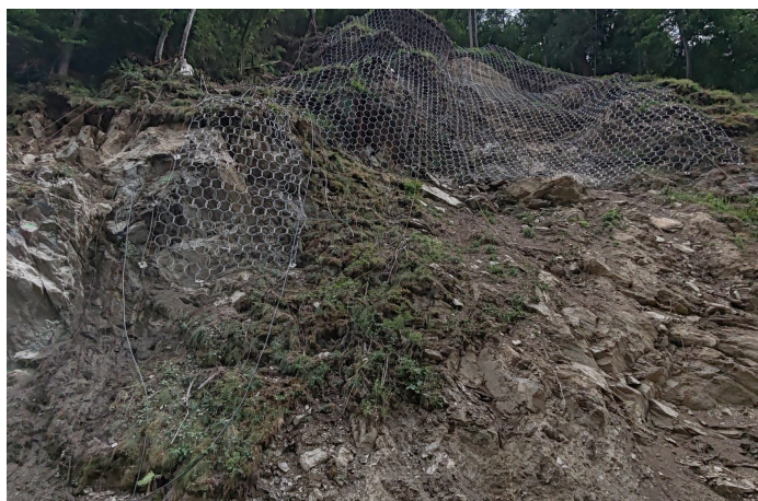
Solutions en cours de pose
