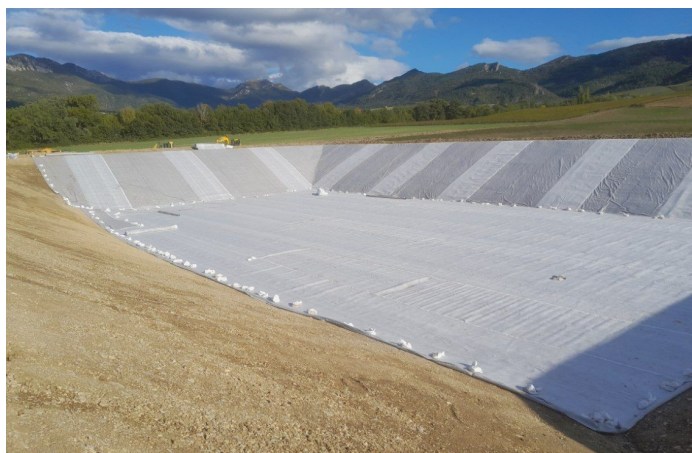
Drainage gaz sous étanchéité de bassin
