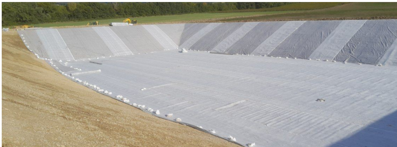
Drainage gaz sous étanchéité de bassin
