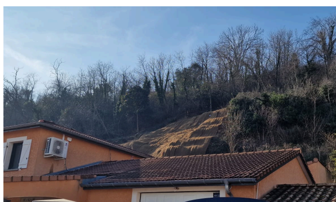
Vue de la protection derrière les habitations
