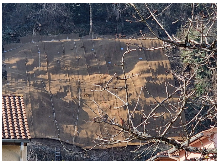
Vue du talus en cours de protection
