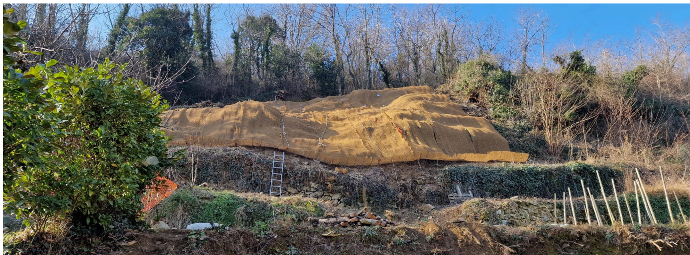
Rouleau de MacMat® HS posé et ancrages en cours
