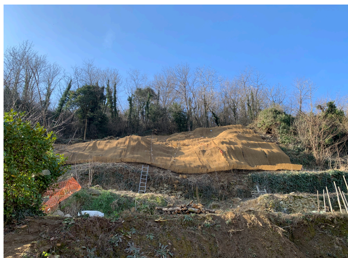
Pose du MacMat® HS 30 en cours
