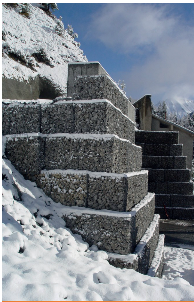
Mur en Cubiroc
