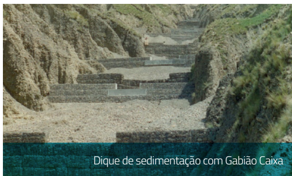
Barragem de sistematização fluvial com Gabião Caixa e Colchão Reno®
