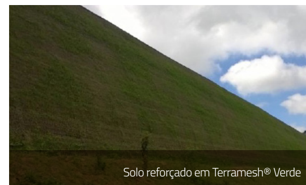
Solo reforçado em Terramesh® System
