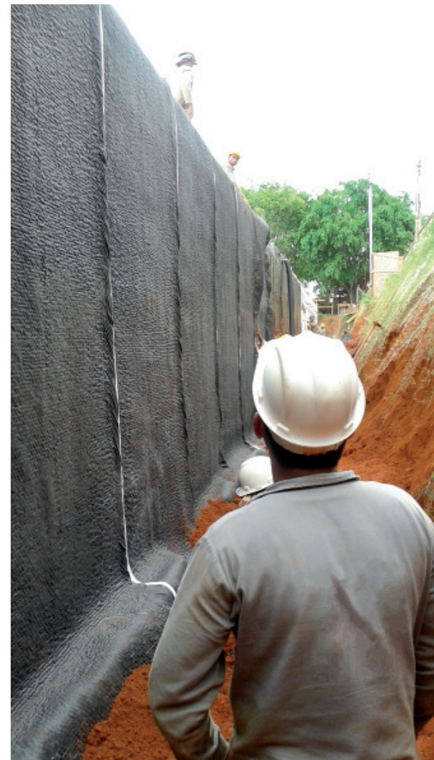
Drenagem predial com geocomposto MacDrain® FP
