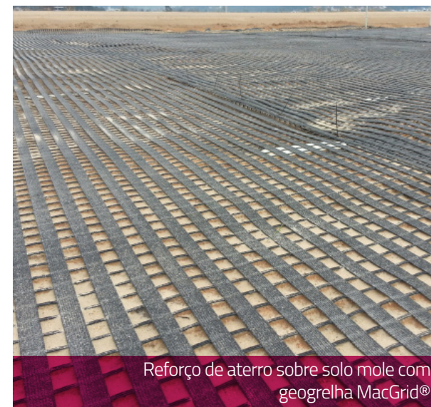
Separação e reforço de solo mole com microgelha MacGrid® Net
