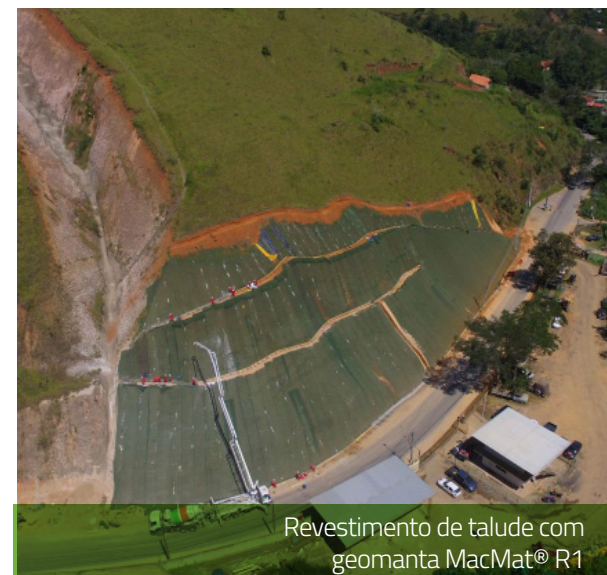
Revestimento de talude com geomanta MacMat® R3
