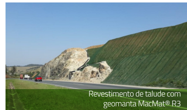
Revestimento de talude com geomanta MacMat® R3
