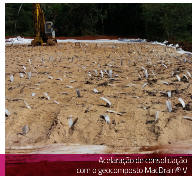
Reforço de aterro sobre solo mole com geogrelha MacGrid® e aceleração de consolidação com o geocomposto MacDrain® V
