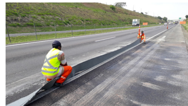
Drenagem de pavimento em microvala com geocomposto MacDrain® TD
