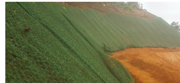
Revestimento de talude com geomanta MacMat® R3
