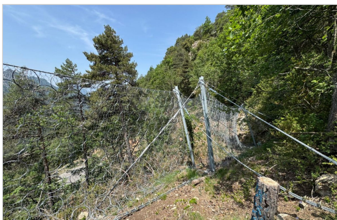
Solape de tramos de la barrera RB1500
