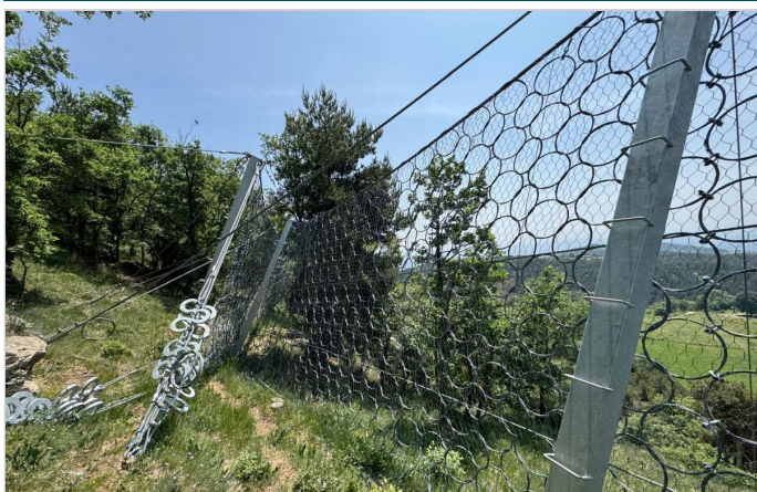
Solape de tramos de la barrera RB3000
