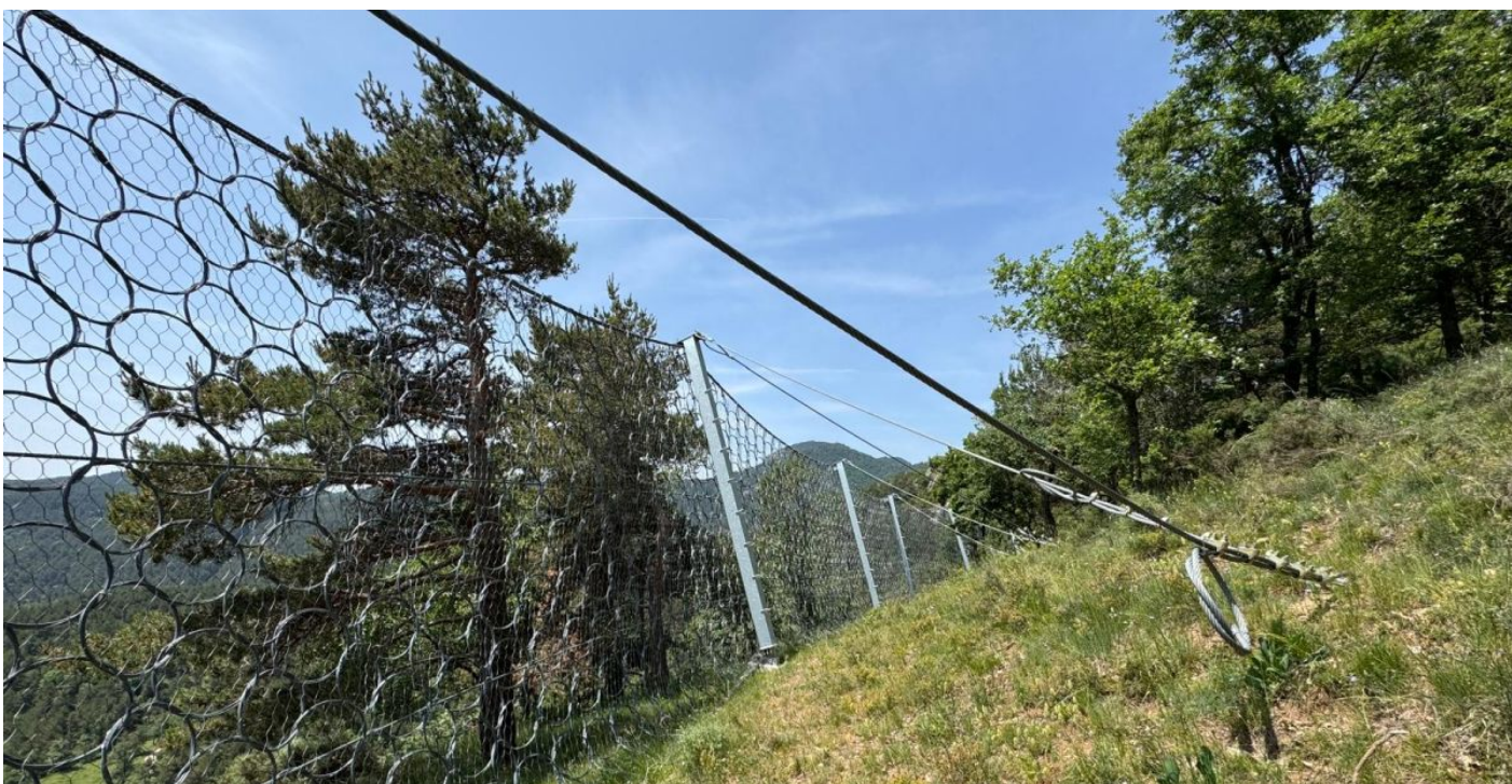
Instalación completada de la barrera RB3000
