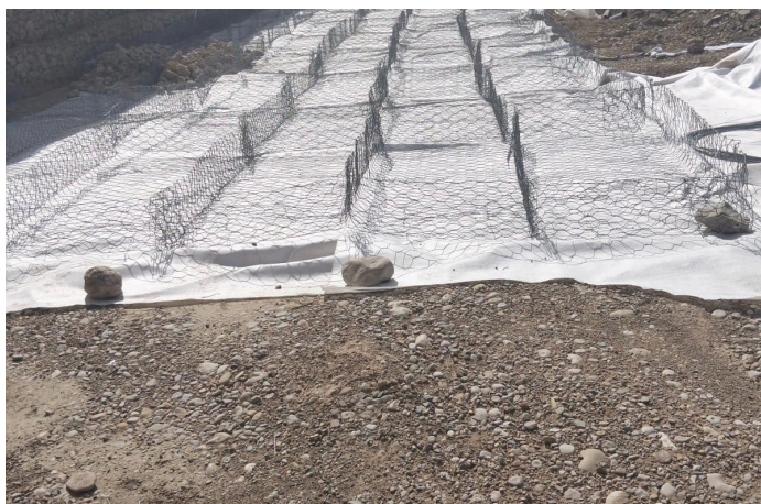
Instalación de los colchones Reno en el lecho del río
