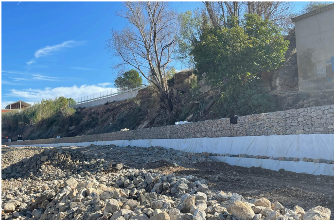
Proceso de ejecución de muro de gaviones
