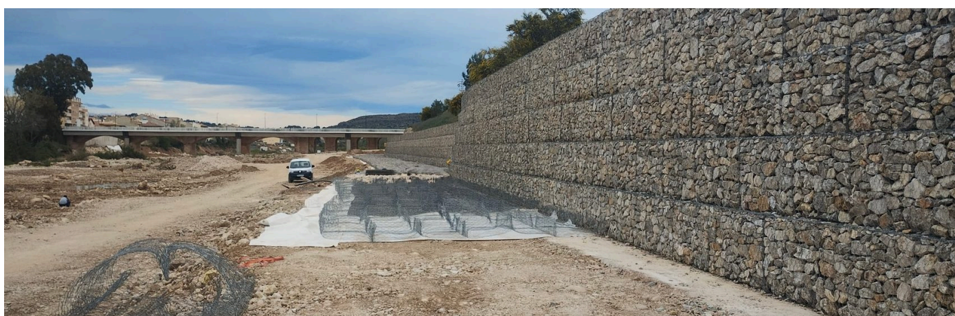
Proceso constructivo de la actuación
