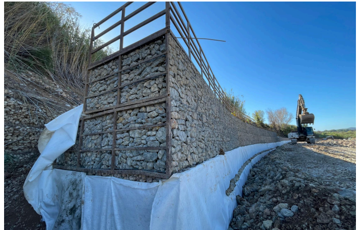
Ejecución de muro de gaviones
