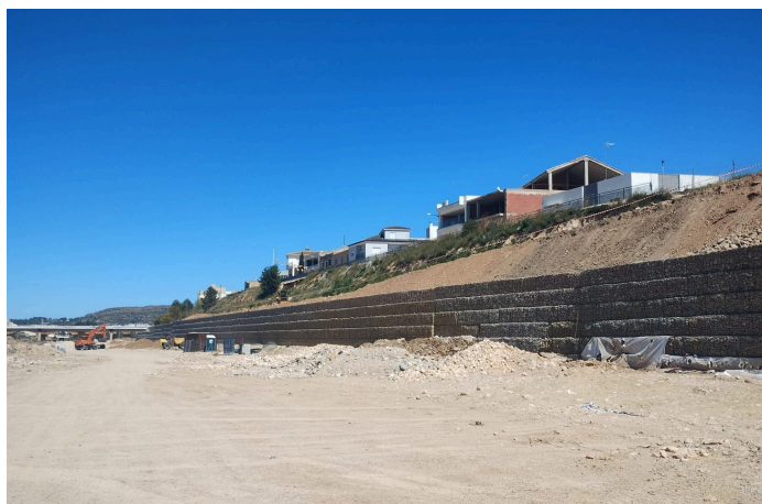
Vista frontal del muro de gaviones
