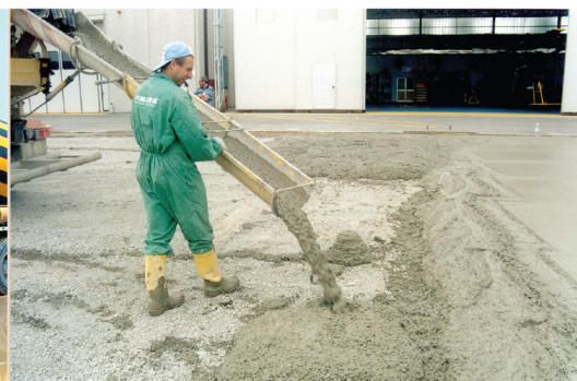
El hormigón reforzado con fibra puede ser vertido directamente desde camión o bombeado
