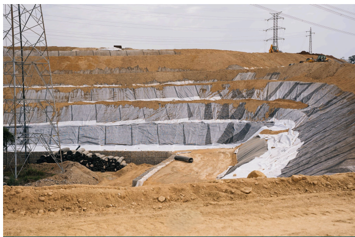
Muro de gaviones en el pie y taludes del vertedero
