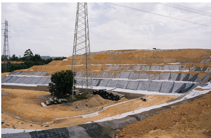
Vista de los taludes y bermas del vertedero
