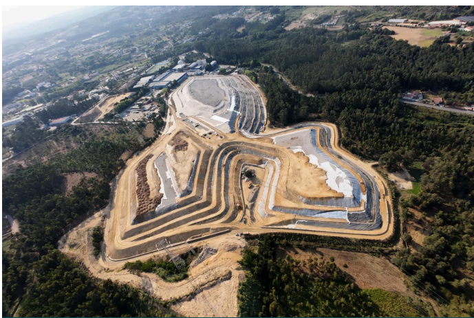
Vista aérea general del vertedero
