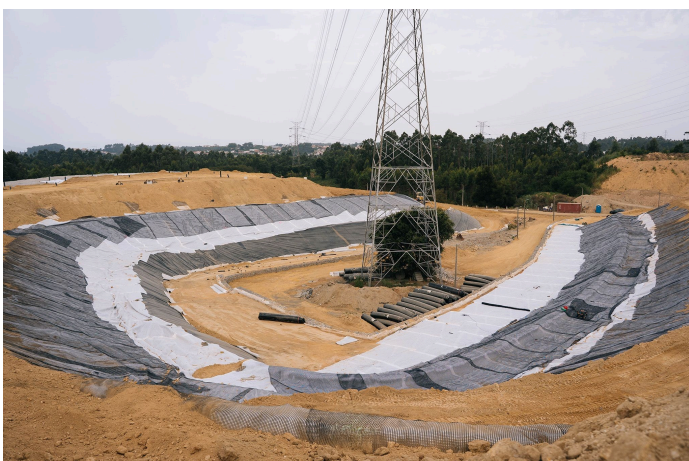
Instalación del MacDrain W y la MacGrid WG
