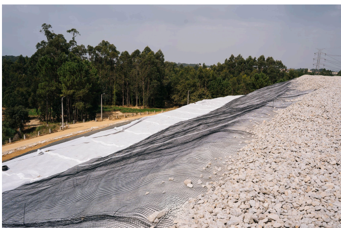
Instalación de la geomalla tipo MacGrid WG
