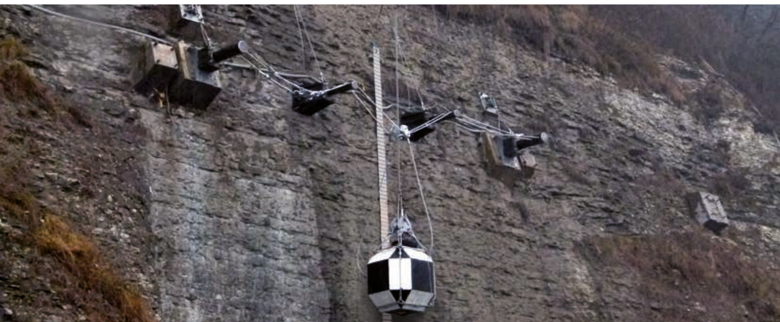
3 : Second impact sans que la structure ne soit réparée
