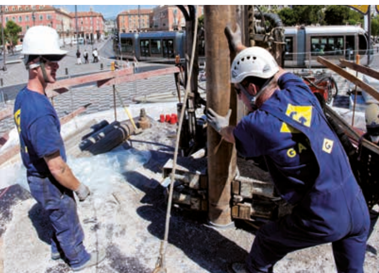
3 : Fondation sur micropieux
