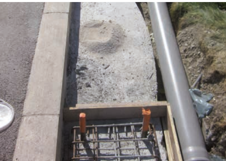
2 : Longrine longitudinale avec barres d'ancrages
