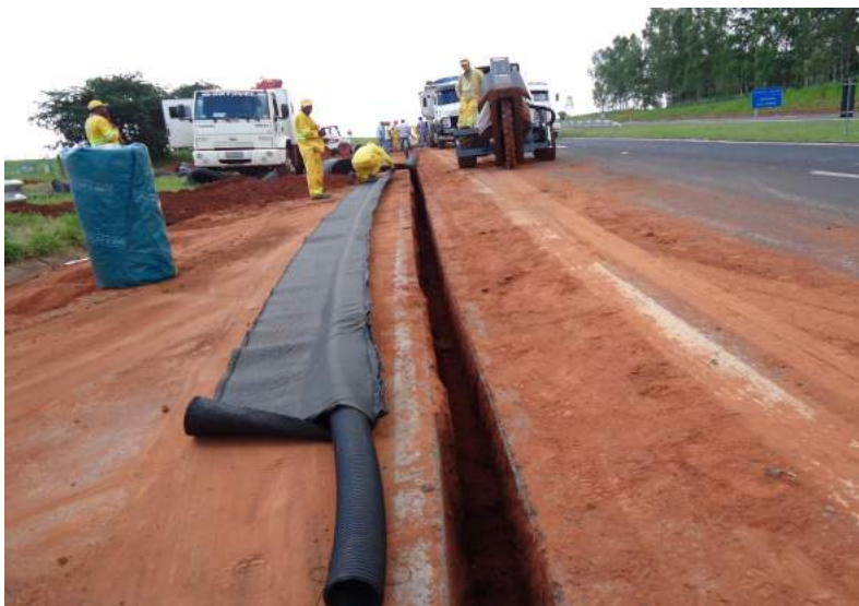
Trincheira drenante com geocomposto MacDrain® TD e MacPipe®
