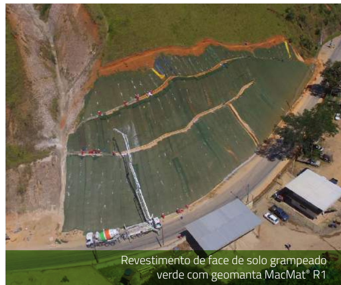
Revestimento de talude com geomanta MacMat® R3
