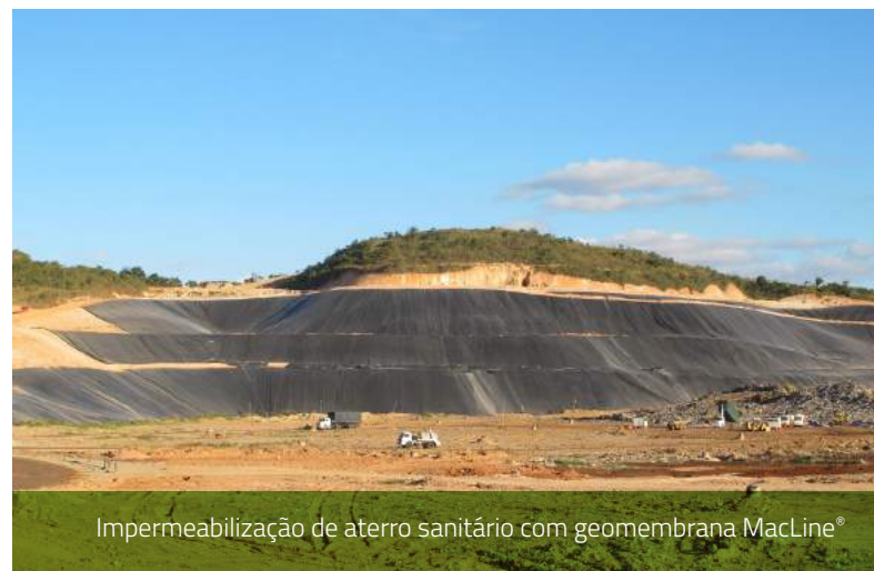
Impermeabilização de aterro sanitário com geomembrana MacLine®
