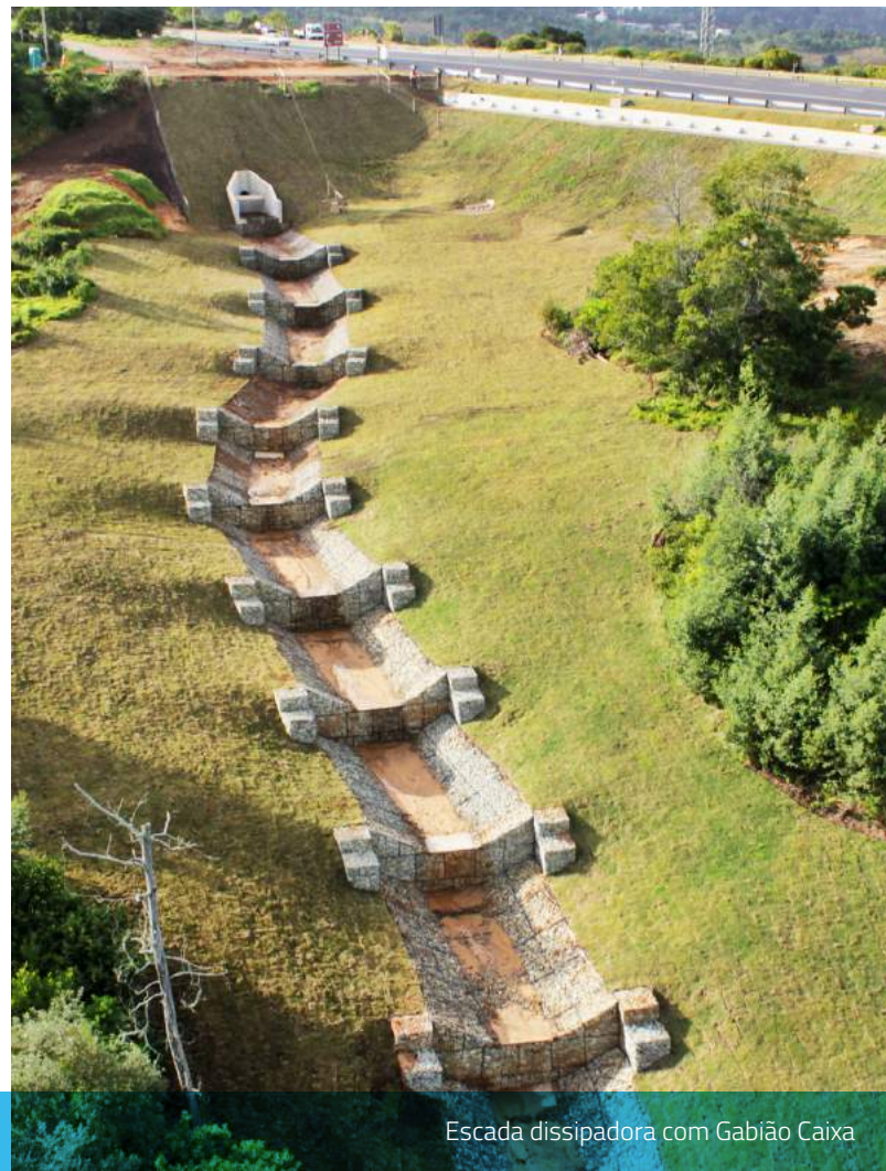
Apoio e proteção de ponte com Gabião Caixa
