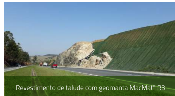
Revestimento de talude com geomanta MacMat® R3
