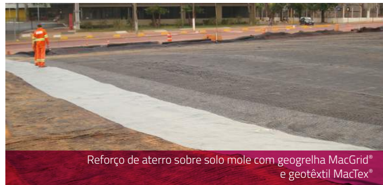
Separação e reforço de solo mole com microgrelha MacGrid® Net
