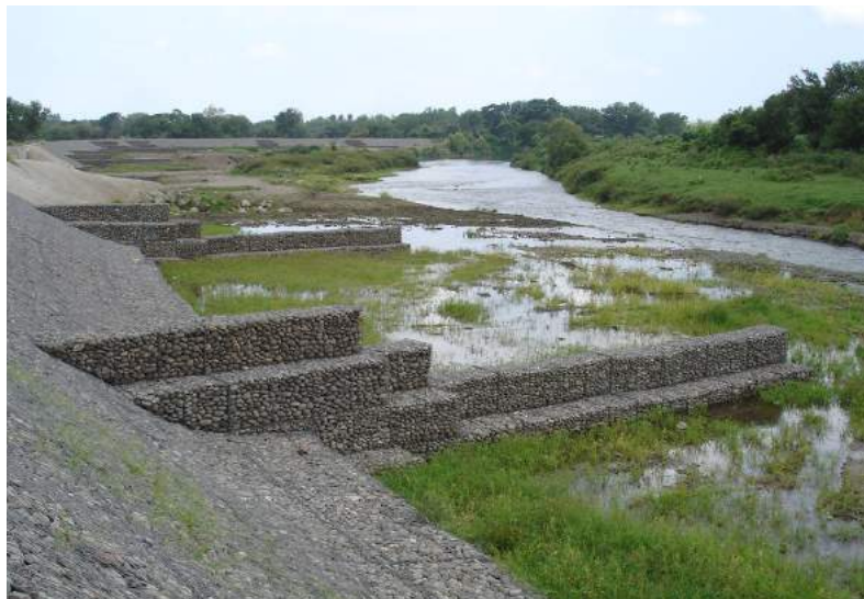
Obra longitudinal em Colchão Reno® com Espigões em Gabião Caixa
