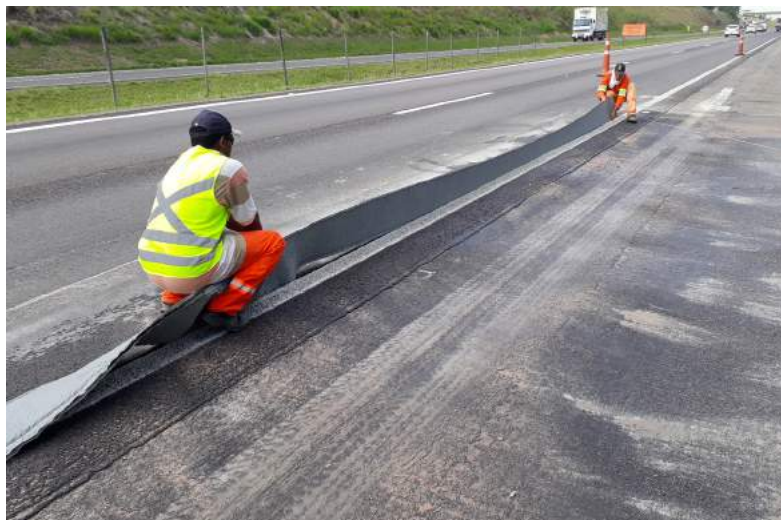
Drenagem de pavimento em microvala com geocomposto MacDrain® TD
