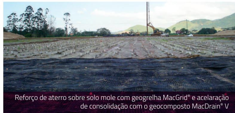
Reforço de aterro sobre solo mole com geogrelha MacGrid® e geotêxtil MacTex®
