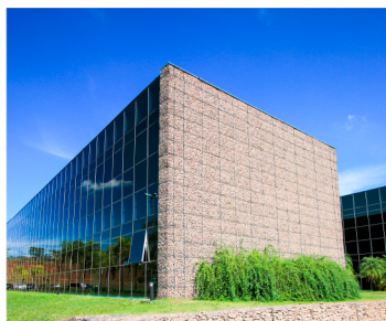
Revestimiento de fachada con Gavión Caja
