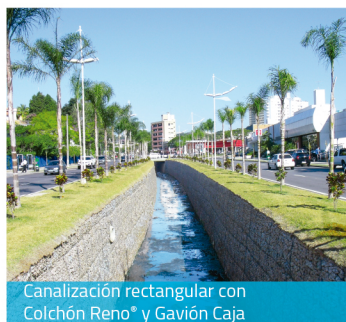
Muro de contención en Gavión Caja
