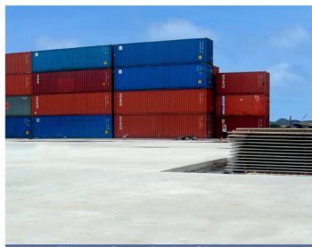
Losa fibro-reforzada con fibras de polipropileno FibroMac®
