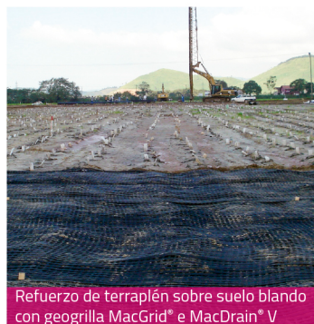
Refuerzo de la base del pavimento con geogrietas MacGrid®
