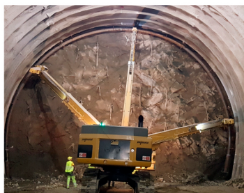
Concreto reforzado con fibras de acero Wirand®
