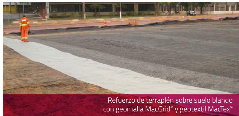
Separación y refuerzo de suelo blando con microgrilla MacGrid® Net
