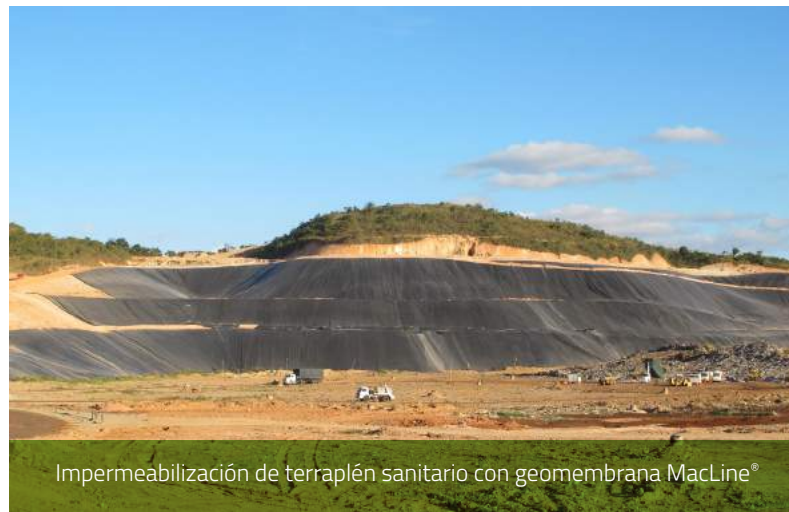
Impermeabilización de terraplén sanitario con geomembrana MacLine®
