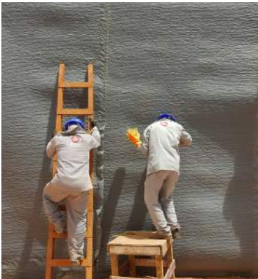
Drenaje vertical con geocompuesto MacDrain®
