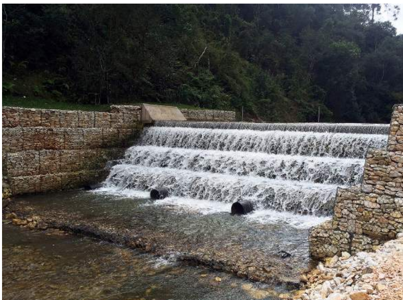
Obra transversal con Gavión Caja
