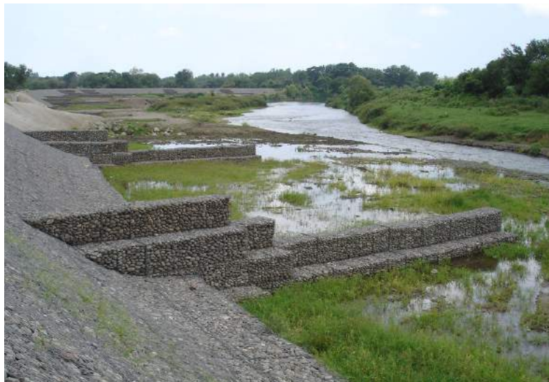
Obra longitudinal en Colchón Reno® con Espigones en Gavión Caja
