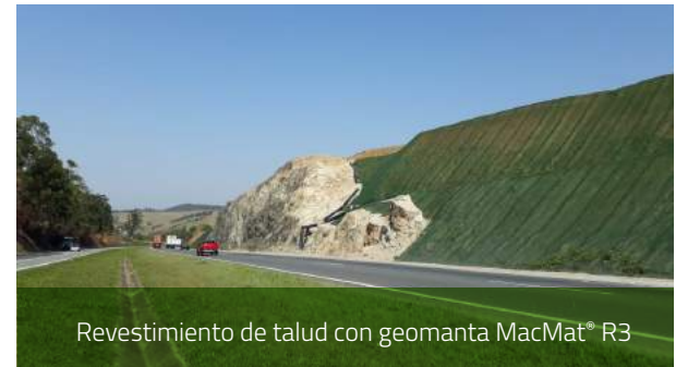
Revestimiento de talud con geomanta MacMat® R3
