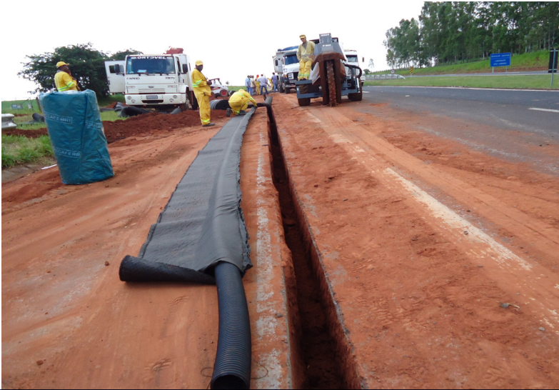
Trinchera drenante con geocompuesto MacDrain® TD y MacPipe®
