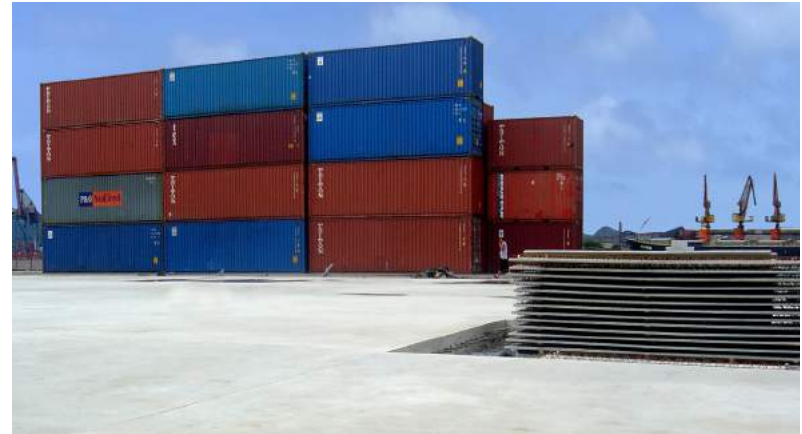
Piso fibro-reforzado con fibras de acero Wirand®
