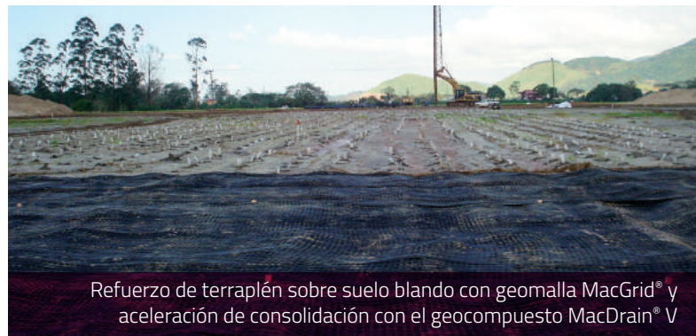
Refuerzo de terraplén sobre suelo blando con geomalla MacGrid® y geotextil MacTex®
