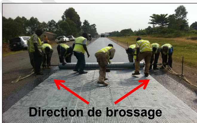
Figure 3: Utilisation des moyens pour assurer une jonction complète
