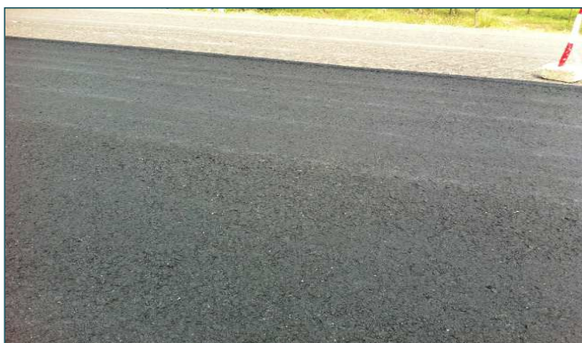
Figure 8: Enrobé placé sur la MacGrid® AR
