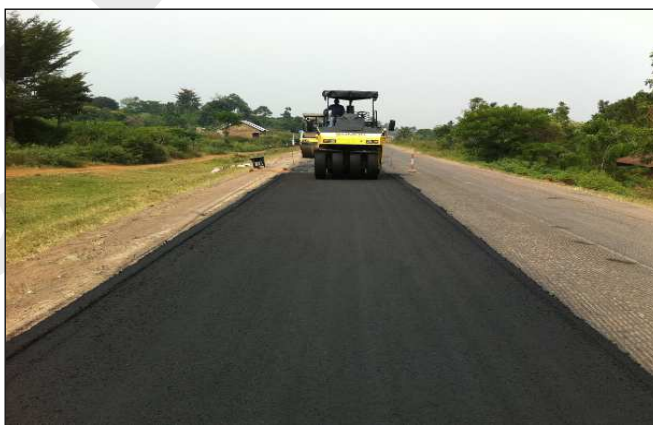
Figure 7: Roulement de l'enrobé
