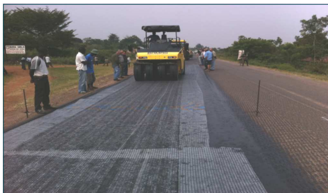
Figure 5: Rouler sur la géogrille avec un rouleau sur pneus
