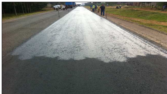
Figure 1: Appliquer l'émulsion d'accrochage
