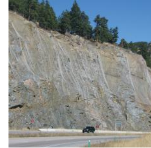
2 Basit tel ağı sistemleri- Yüzeysel örtüleme
