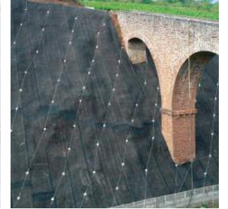
6 Zemin çivisi ve yüzeysel stabilizasyon uygulamaları
